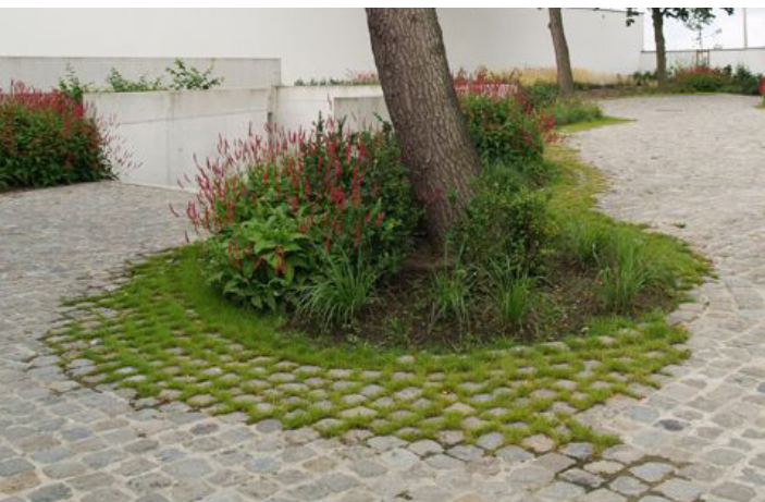
Abb. 39: versickerungsoffener Pflasterbelag . durchgrünte Fuge
