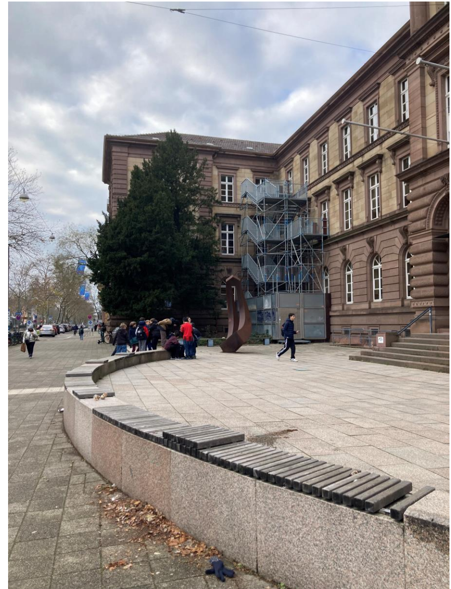
Foto Gerüsttreppe Hauptgebäude
