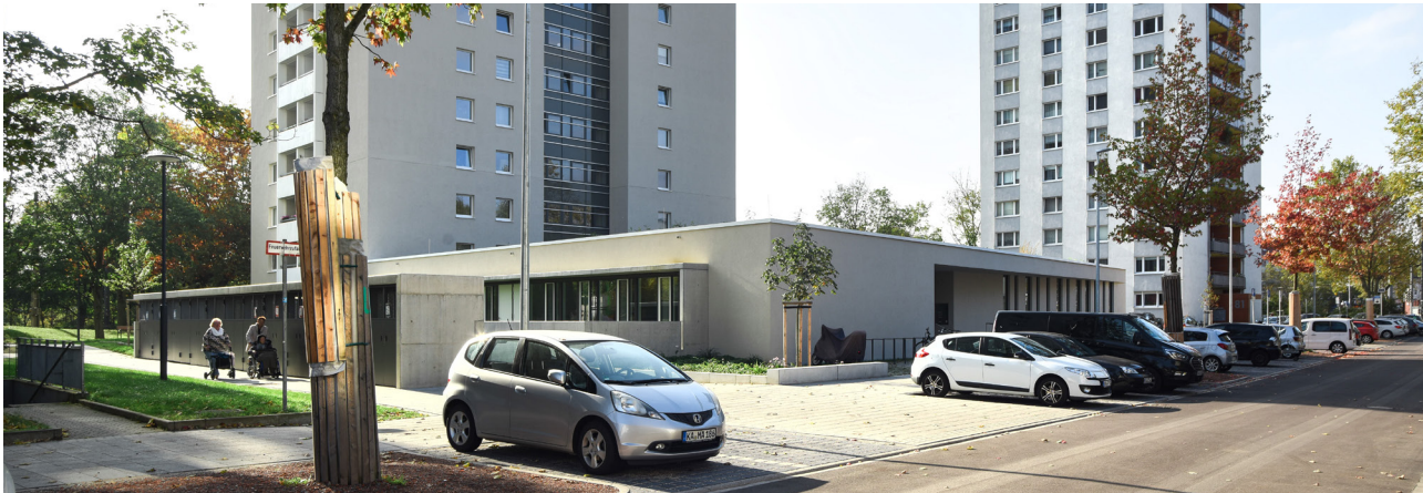
Neu errichtetes „Stadtteilzentrum Mühlburg“ mit Bibliothek sowie renovierte Wohnhochhäuser, Foto: Stadtplanungsamt, 2019
