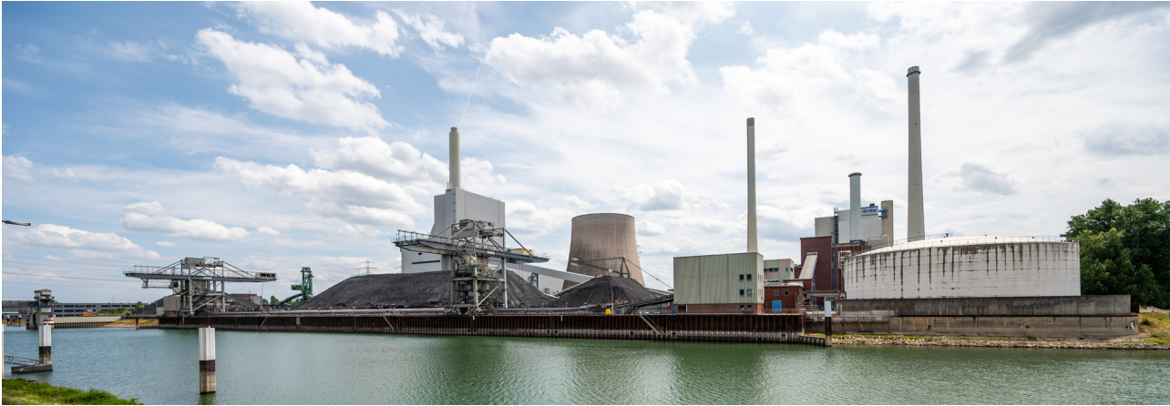
Rhein-Hafen-Dampfkraftwerk mit Kohlelager, Foto: Presse- und Informationsamt, 2023
