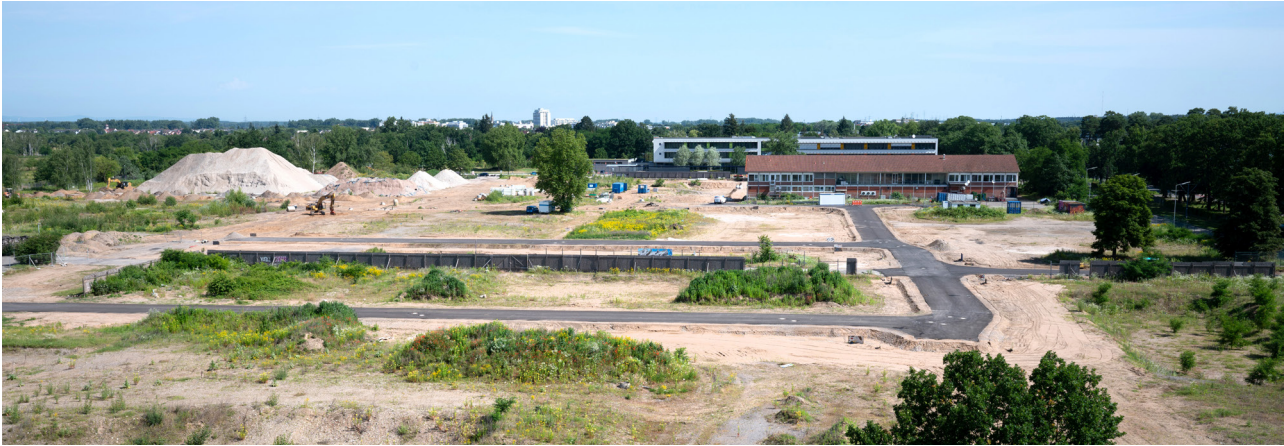
Bauarbeiten zur Erschließung des Gebiets „Zukunft Nord“, Foto: Presse- und Informationsamt, 2024
