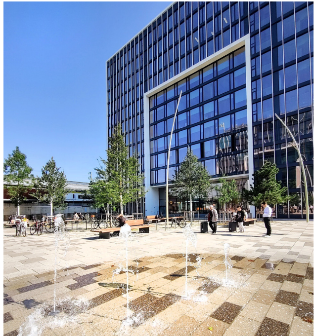
Fontänenfeld an der Südseite des Hauptbahnhofs Foto: Stadtplanungsamt
