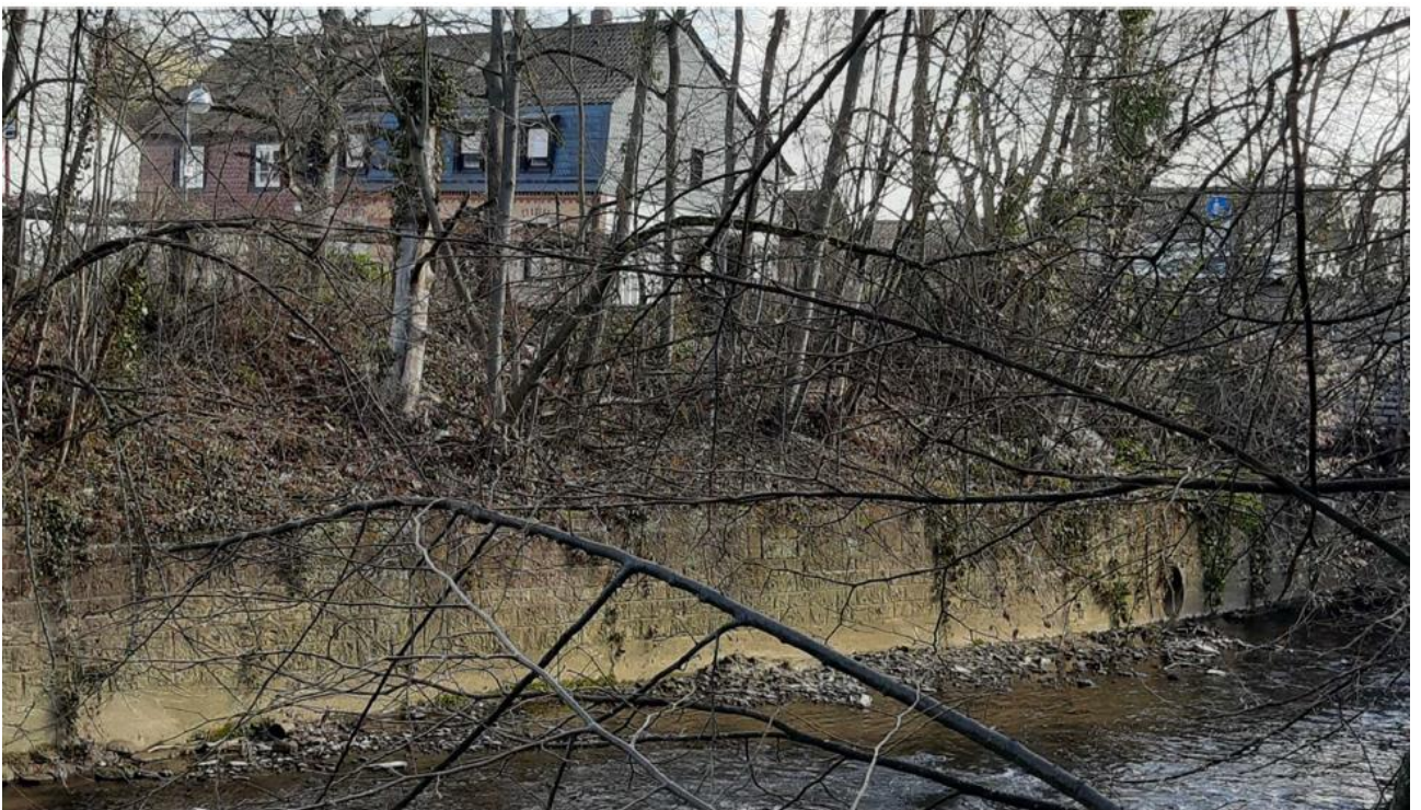
Bild 6: Bestandsmauer mit Sandsteinverblendung Bereich vor Brücke
