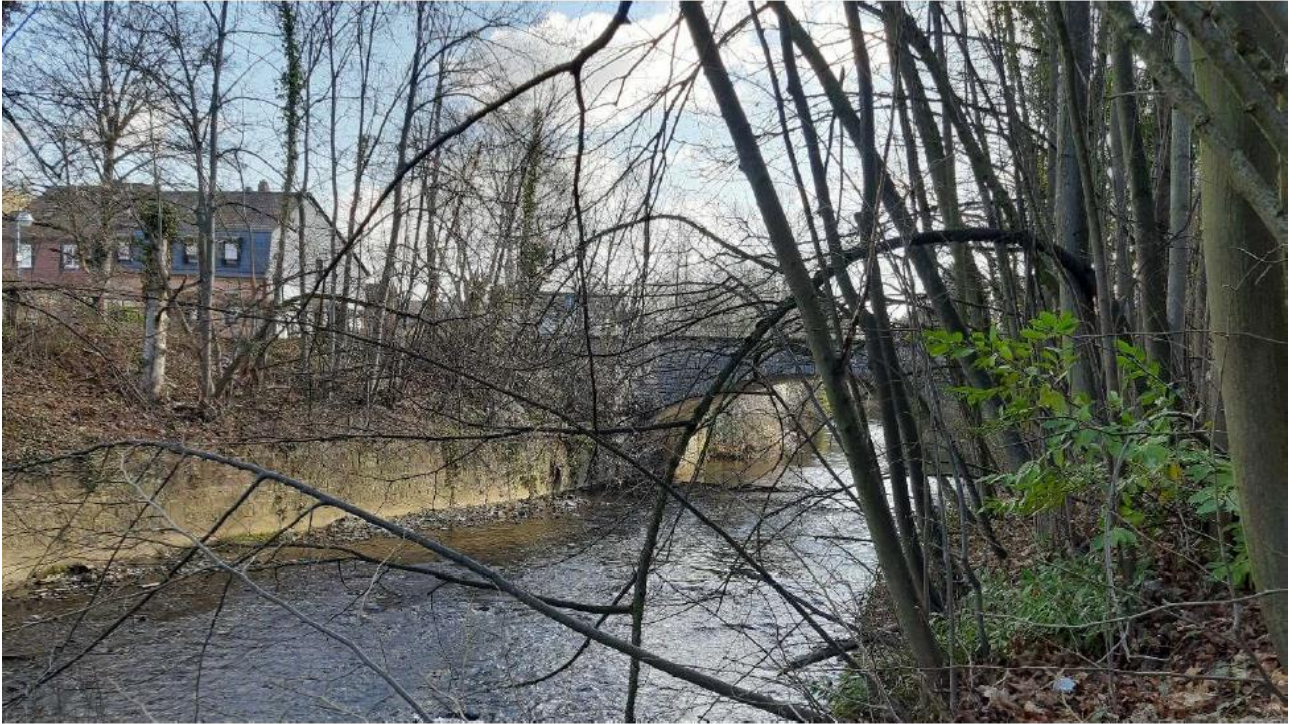
Bild 5: Bestandsmauer Abschnitt unmittelbar vor Brücke Friedrichstraße
