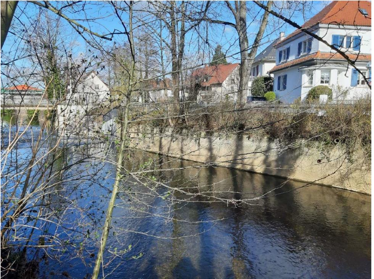
Bild 1: Blick auf Pfinzufermauer Richtung (ehemaligem Mühlwehr)
