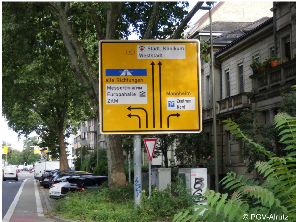
Bild 7: Die einzige Vorwegweisung befindet sich in der Kriegsstraße Ost. Es gab mehrfach Unfälle, teilweise auch folgenschwer, die sich in Folge von kurzfristigen Fahrstreifenwechseln von Kfz ereigneten. Besonderes Risiko von folgenschweren Unfällen, wenn vom Linksabbiegestreifen doch geradeaus gefahren wird (insbesondere wenn dies während der laufenden Linksabbiegephase geschieht, bei der auch der entgegenkommende Linksabbiegender fährt/grün hat).
