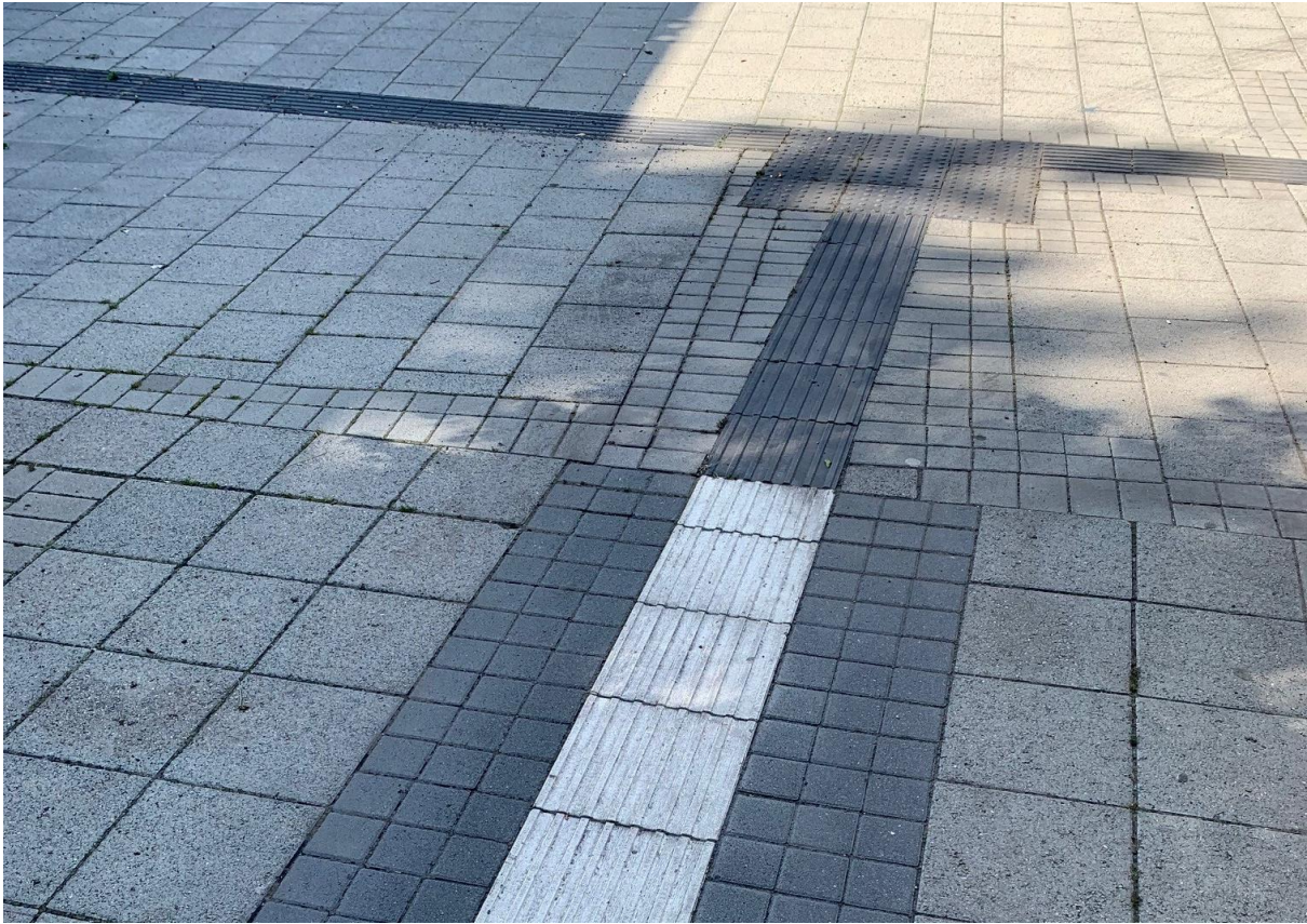
verschiedene Blindenleitsysteme, Pflaster mit unterschiedlichen Verlegerichtungen und -arten
