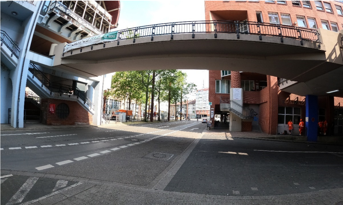
Abbildung 3: Foto-Dokumentation im Untersuchungsgebiet (Brücke über Fritz-Erler-Straße)
