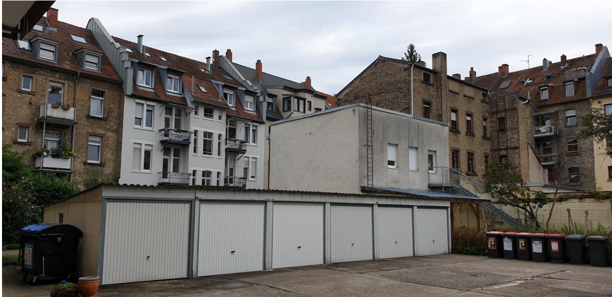
Abbildung 15: Verschiedene Dachzustände (Blick Richtung Winterstraße)
