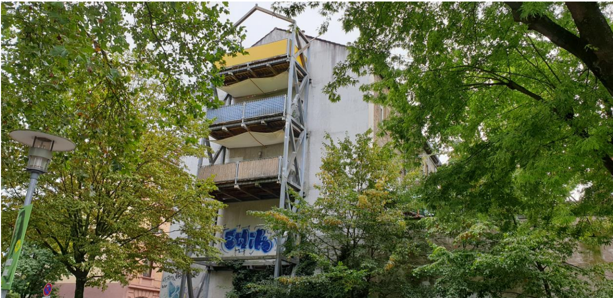
Abbildung 20: Nachträglich angebrachte Balkone (Wilhelmstraße)
