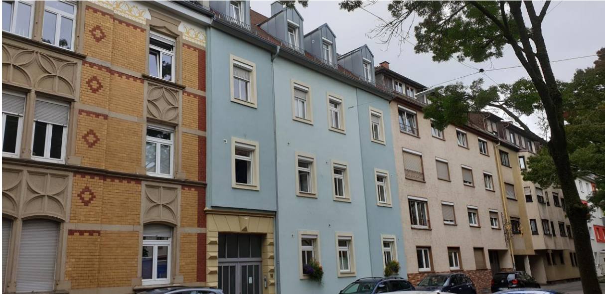
Abbildung 9: Gründerzeithaus mit Fassadendämmung (Scherrstraße)
