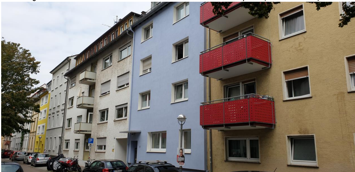
Abbildung 8: Gebäude mit GEG-konformem Wärmedämmverbundsystem (Schützenstraße)
