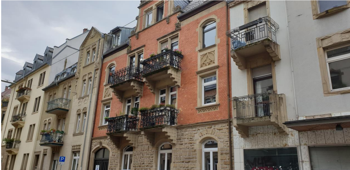
Abbildung 5: Sanierte Fassade (Wilhelmstraße)
