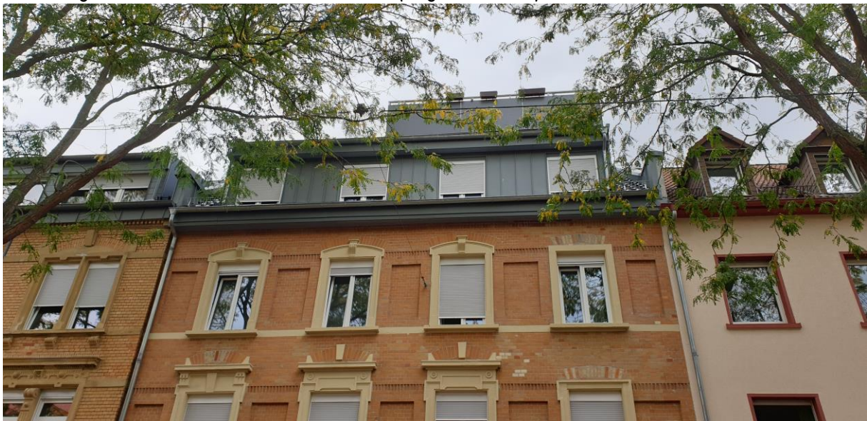
Abbildung 12: Große Gaube mit Dachbalkon (Augartenstraße)
