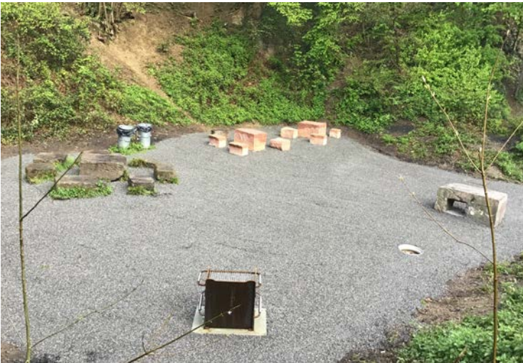
Grillplatz – Vandalismus - sicher
