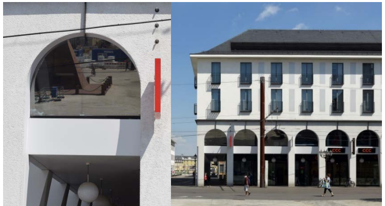
Betonfertigteilfeassade Kaiserstraße 72 – 74a
