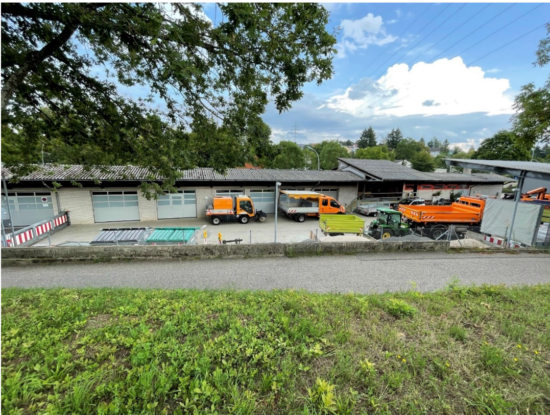
Bauhof Wettersbach, Wiesenstraße 38
