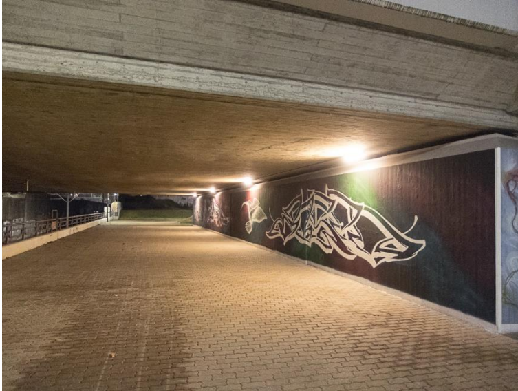
Unterführung Franz-Lust-Straße mit 4 neuen LED-Leuchten
