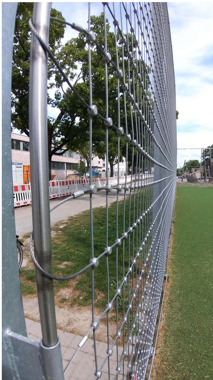
Lärmreduzierender Ballfangzaun an der Fanny-Hensel-Anlage
