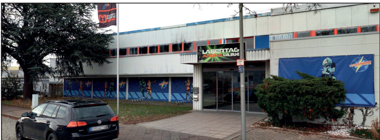
Abb. 10: Beispiel eines Freizeit-Centers, hier: Lasertag Arena, Karlsruhe Hagsfeld Foto: CycloMedia für Stadt Karlsruhe
