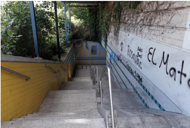
Abbildung 73: Abgang Unterführung Untermühsiedlung – Durlach Bhf
