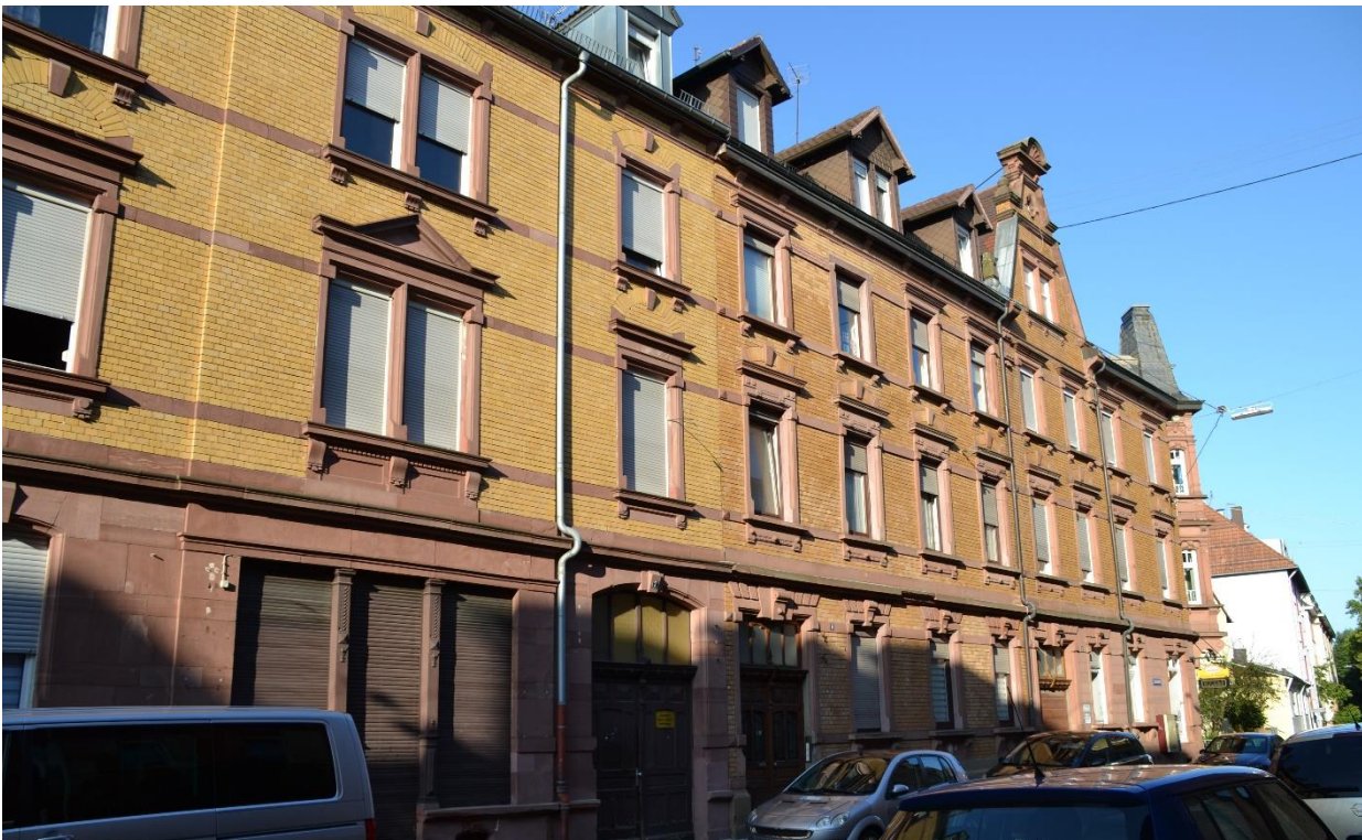
Abbildung 2: Historische Bausubstanz mit energetischen Mängeln
