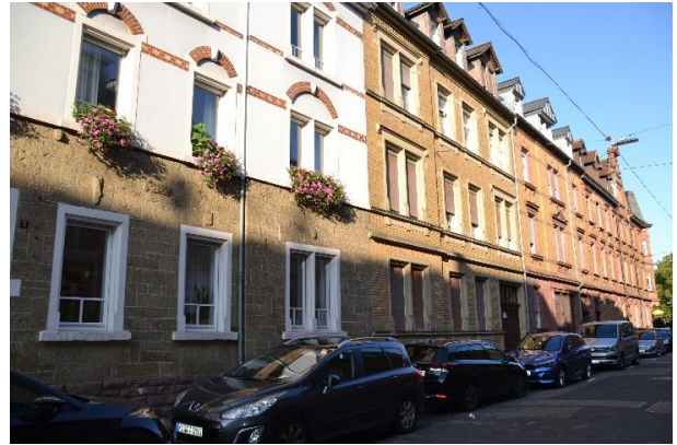
Abbildung 49: Historische Bausubstanz mit energetischen Mängeln
