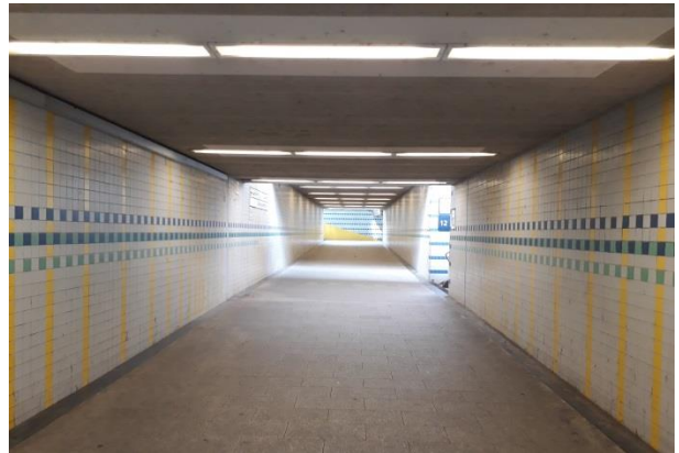
Abbildung 74: Bahnofsunterführung Untermühsiedlung – Durlach Bhf
