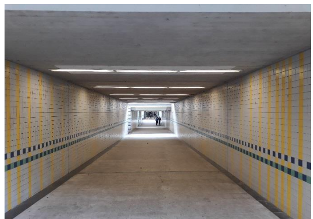
Abbildung 50: Fußgängerunterführung am Bahnhof
