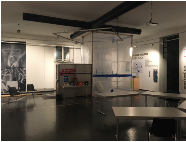
Deckenuntersuchung im Rahmen der Planungen zur Sanierung des Prinz-Max-Palais, Foto: Stadtmuseum
