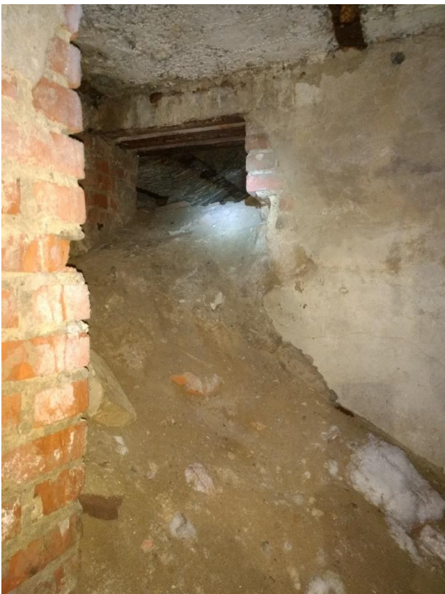
Abbildung 15 (Foto: Flurneuordnungsamt): Im kleinen Raum hinter dem Luftschutztunnel, endend an der Grenze zum Nachbargrundstück Ritterstraße 32. Die mutmaßliche Türleibung verbindet nach außen. Vermutlich handelt es sich um eine Luftschutzeinrichtung, die eine Verbindung nach außen sicherstellen sollte
