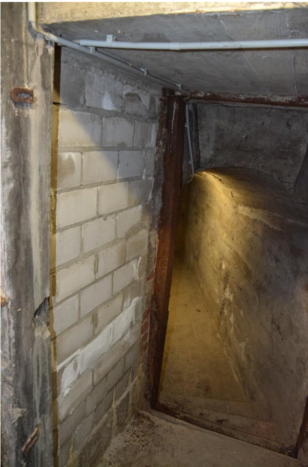
Abbildung 12: Am Ende des schmalen Gangs des ehemaligen Zellenttraktes. Links Zumauerung 1998 des einstigen Kellerzugangs vom Hof aus (vgl. Abbildung 1, Markierung A). Zarge einer ehemaligen Luftschutztür, dahinter Treppenabgang zum Luftschutztunnel
