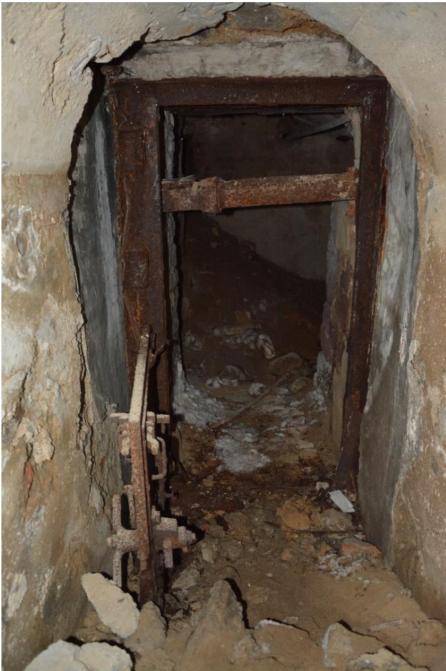
Abbildung 14: Am Ende des mit Bauschutt angefüllten Luftschutztunnels. Überreste einer Luftschutztür, dahinter ein kleiner Raum, gefüllt mit Bauschutt
