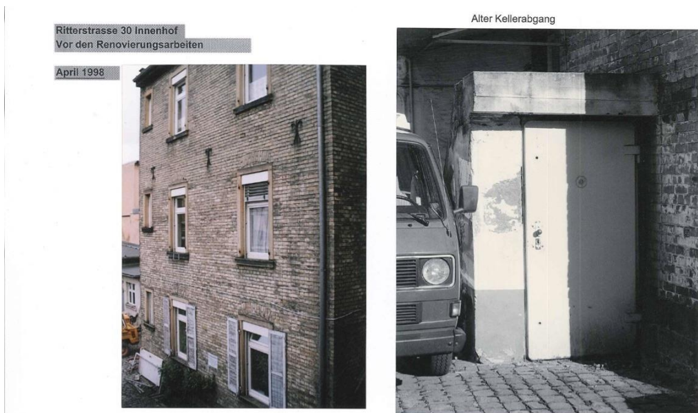
Abbildung 3 (Foto: Flurneuordnungsamt: Seitengebäude im Hof, in dessen Kellergeschoss sich der ehemalige Zellentrakt befindet. Ehemaliger Kellerzugang vom Hof aus, 1998 abgebrochen und im Keller zugemauert. Sichtbar die betonierte Luftschutzverstärkung
