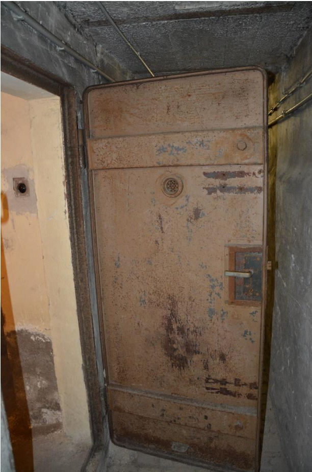
Abbildung 8: Tür zur ehemaligen zweiten Zelle. An der einstigen Luftschutztür wurde der beidseitige Schließ- und Öffnungshebel entfernt, wodurch die Einschlussmöglichkeit gegeben war
