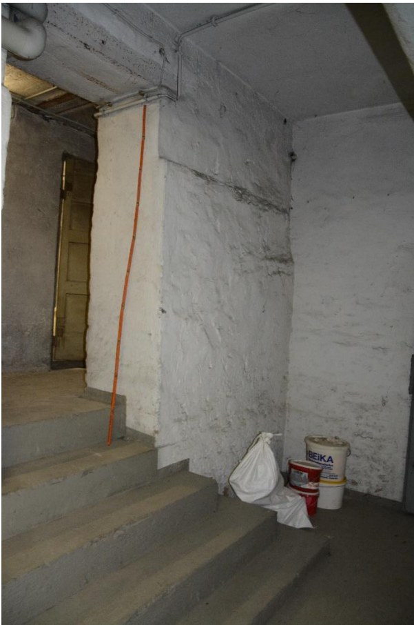
Abbildung 2: Zugang zum ehemaligen Zellentrakt im Keller, sichtbar das erhöhte Niveau zum übrigen Kellerteil
