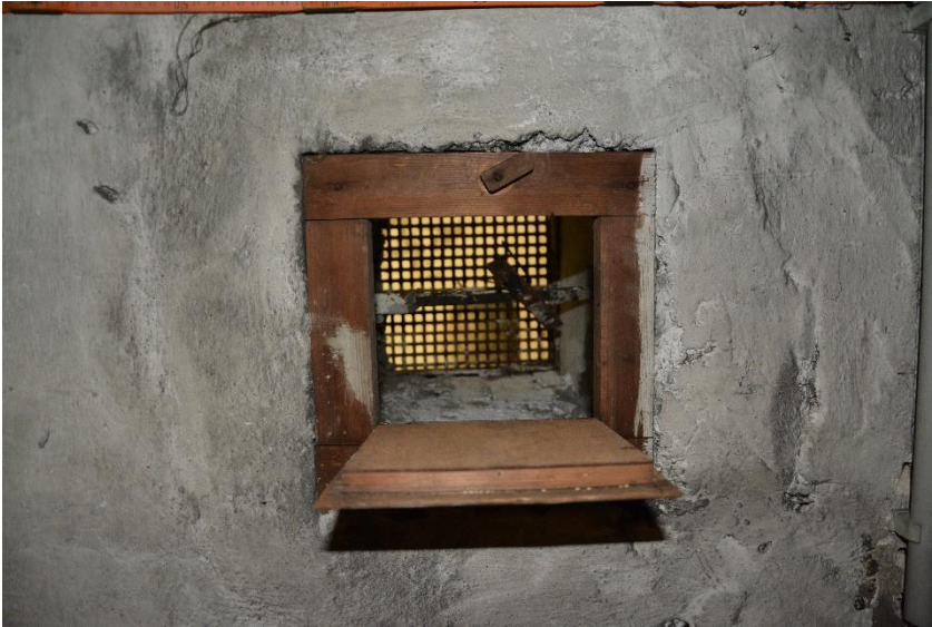
Abbildung 6: Kontrollluke zur ersten Zelle
