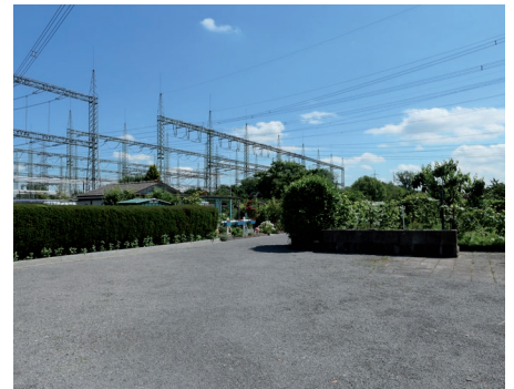
Durchwegung mit Umspannwerk im Hintergrund
