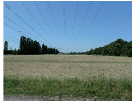
Lage der Anlage unter einer Hochspannungsleitung
