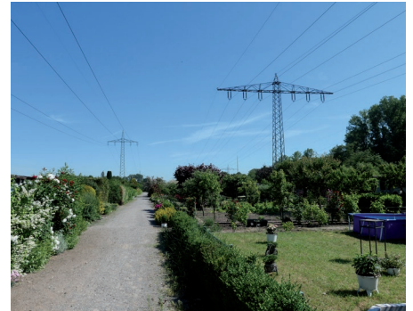
Lage der Anlage unter einer Hochspannungsleitung
