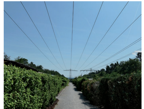
Lage der Anlage unter einer Hochspannungsleitung
