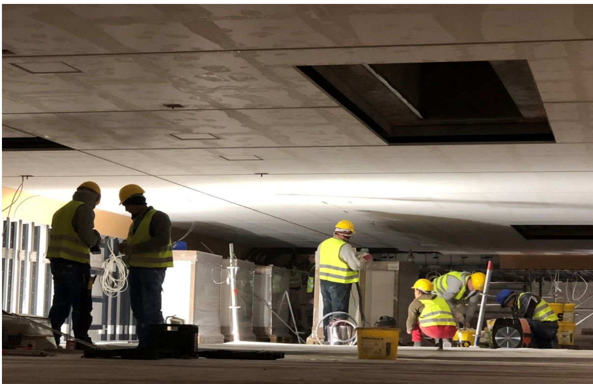
Haltestelle Kronenplatz: Arbeiten an der Deckenverkleidung
