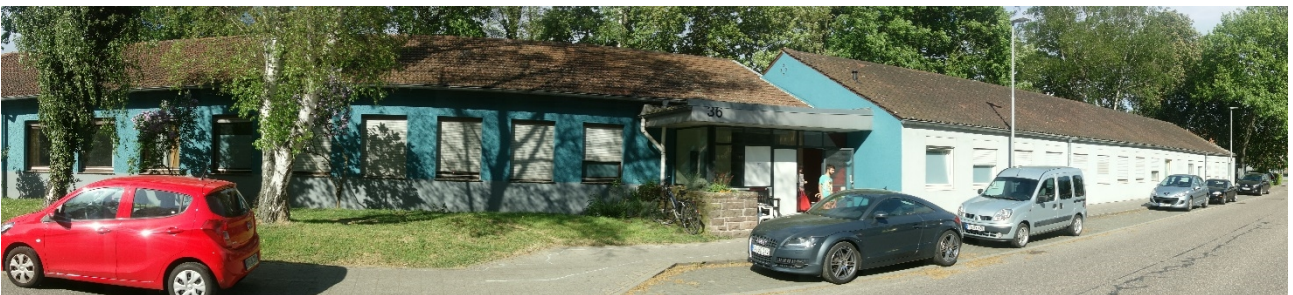
Zum Abriss vorgesehene Bestandsbebauung nördlich der Eisenbahnstraße
