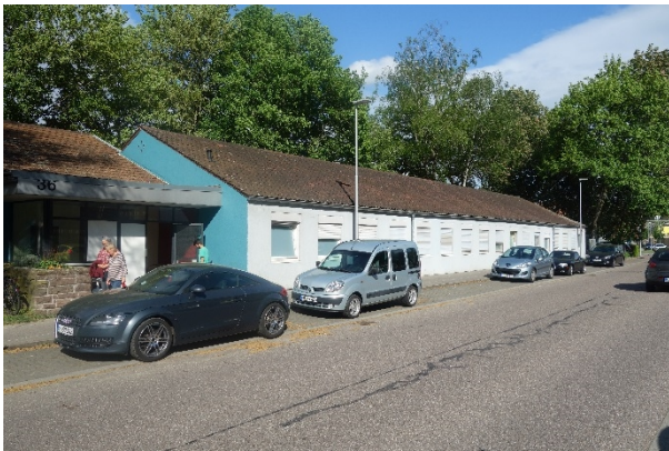
Zum Abriss vorgesehene Bestandsbebauung nördlich der Eisenbahnstraße
