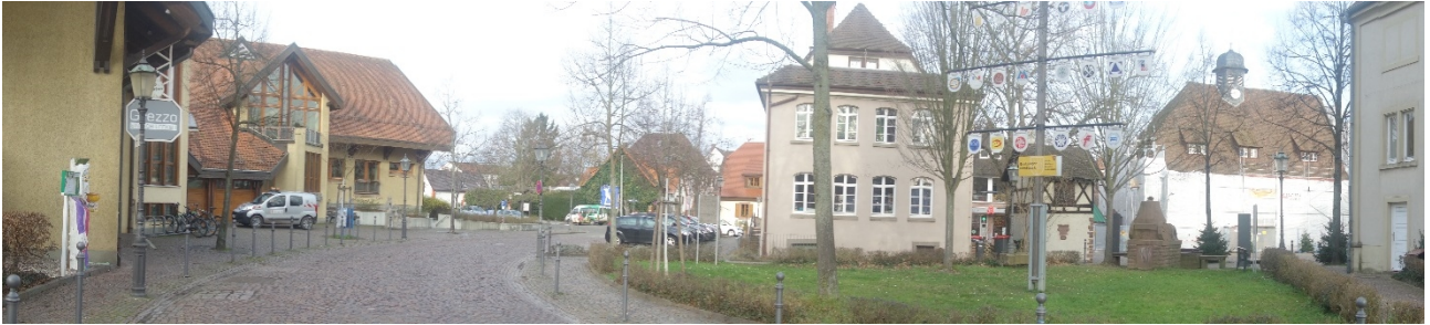
Fuge zwischen Rathaus und Begegnungsstätte
