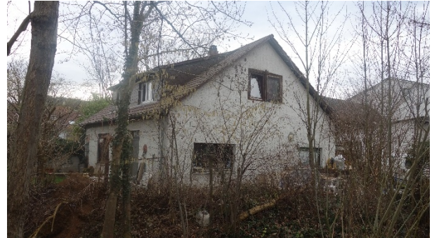
Wohngebäude im Rückraum des Blockinnenraums
