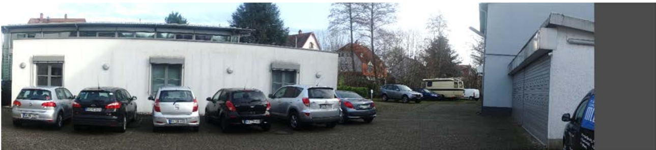
Rückseite/ Anbau Sparkasse mit Parkierung im Blockinnenraum
