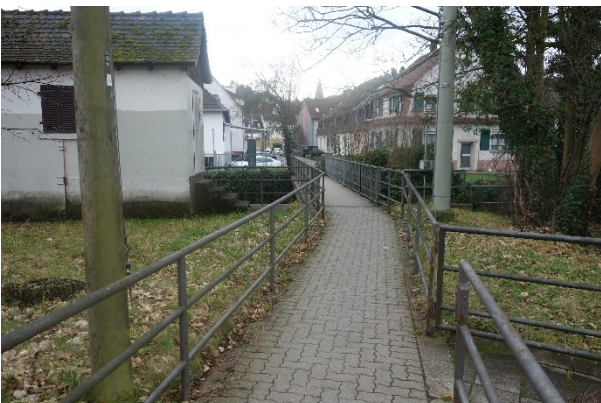
Brückenbauwerk über die Pfinz ( Anbindung Nahversorgung)
