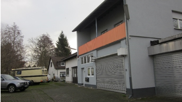
Rückwärtige Bebauungsstruktur hinter Sparkasse
