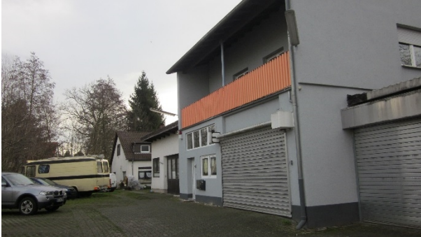
Rückwärtige Bebauungsstruktur hinter Sparkasse
