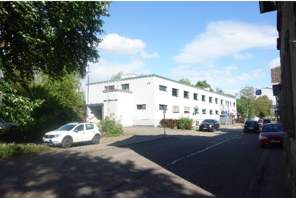
Verlauf der Eisenbahnstraße / Vorfeld Bahnhof
