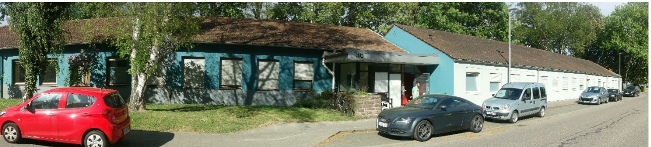
Zum Abriss vorgesehene Bestandsbebauung nördlich der Eisenbahnstraße
