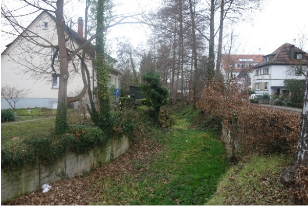
Verlauf des Mühlgrabens südlich Straße An der Pfinz
