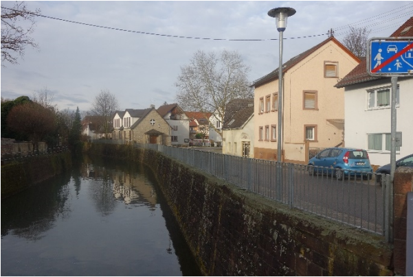
Mülhstraße mit Verbauung entlang der Pfinz
