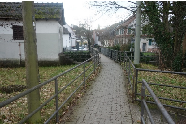
Brückenbauwerk über die Pfinz ( Anbindung Nahversorgung)
