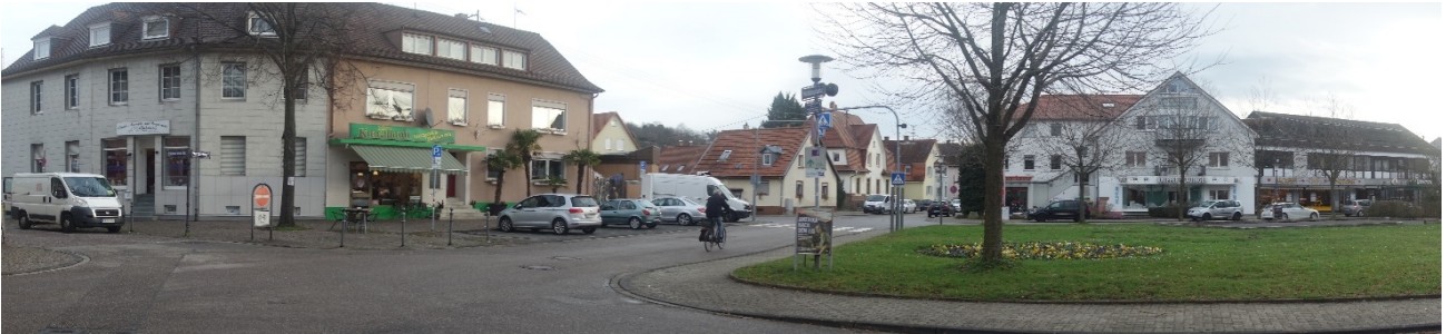
Blick auf den Nordrand des Niddaplatzes mit Vorfeldern entlang der Straße An der Pfinz
