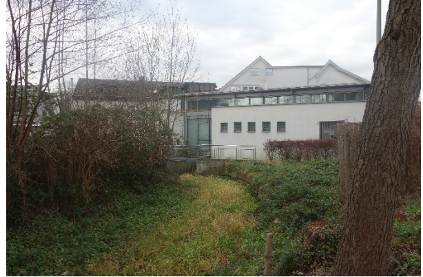
Ende des Mühlgrabens vor Verdohlung an Sparkasse
