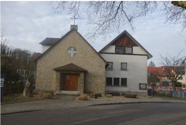
Fehlendes Netzelement zwischen Mülhstraße und Büchelstraße
