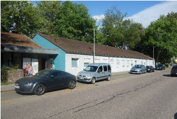
Zum Abriss vorgesehene Bestandsbebauung nördlich der Eisenbahnstraße
