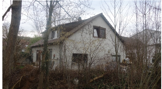
Wohngebäude im Rückraum des Blockinnenraums
