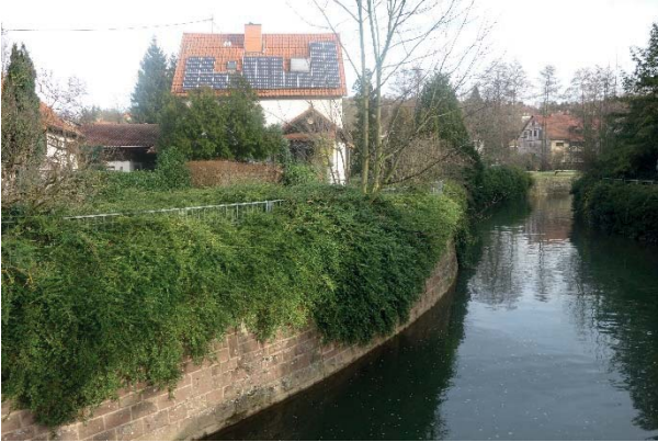
Fehlendes Netzelement zwischen Mühlstraße und Mühlwehr
