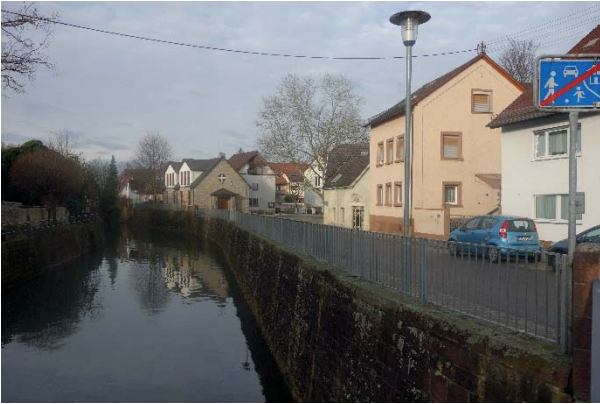
Mühlstraße mit Verbauung entlang der Pfinz
