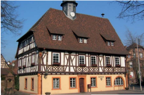
Altes Rathaus, Bauamt I
