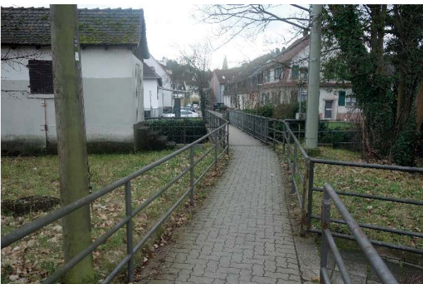
Brückenbauwerk über die Pfinz ( Anbindung Nahversorgung)
