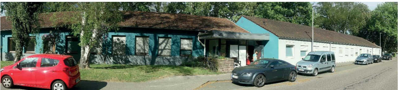
Zum Abriss vorgesehene Bestandsbebauung nördlich der Eisenbahnstraße
