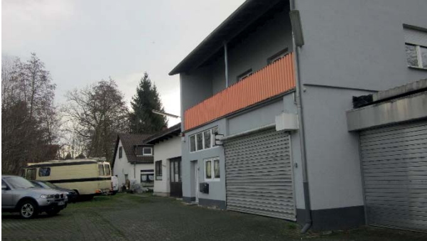
Rückwärtige Bebauungsstruktur hinter Sparkasse
