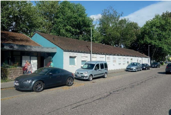
Zum Abriss vorgesehene Bestandsbebauung nördlich der Eisenbahnstraße
