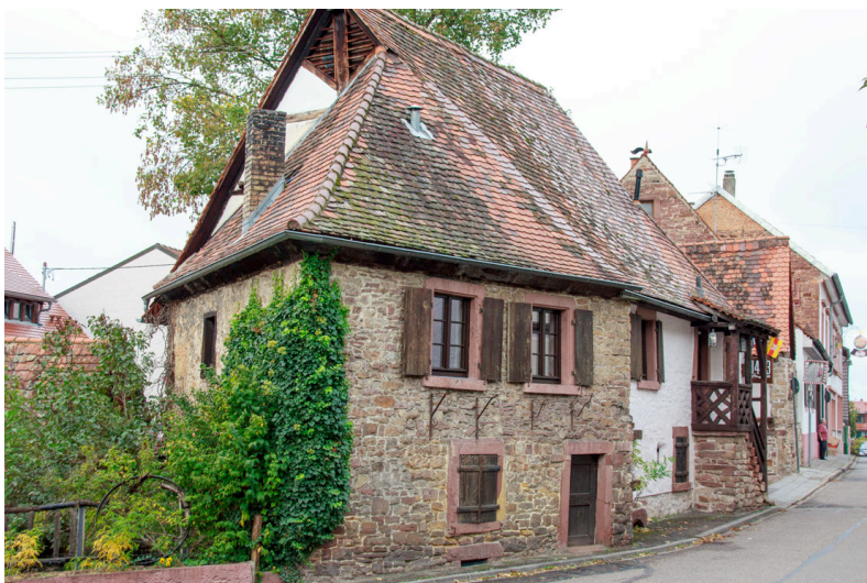
Hofanlage, heute „1463“ Apartmenthaus / Seminarraum / Jacques Meyer's Culinarium, Friedrichstr. 10 - 14 (Flst. 646, 655), Grötzingen. Im Kern 15. Jh., Fristsäulenständerhaus, ehem. Altenteil, Scheune, Werkstatt (Sachgesamtheit). Wahrscheinlich ältestes Gebäude im Karlsruher Stadtgebiet. Denkmal nach § 2 (Kulturdenkmal) Denkmalschutzgesetz. Foto: Titus Tamm 2017
