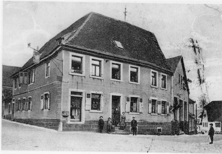
Aufnahme Gasthaus "Goldener Ochsen" von 1915. Fachwerkgebäude mit Torbogen, Torbogen 1618. Fachwerkgebäude wohl von 1586 lt. Heimatbuch Mössinger. Vorher Standort des Gasthof „Roter Ochsen“ Bj. vor 1532. Davor evtl. Weinschänke in Klosterbesitz (Keller erhalten). Wiederaufbau 1699 lt. Ochsen-Historie Huber. Heutiger Fassadenzustand Anfang 19. Jh, mehrfach überputzt. Im Inneren wohl älter (1586). Ältester Gasthof Grötzingens. Denkmal nach § 2 (Kulturdenkmal) Denkmalschutzgesetz. Foto: Pfinzgaumuseum UI 2379 (oben)
