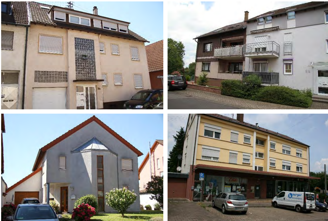
Abbildung 15: Gebäude mit gestalterischen Mängeln
