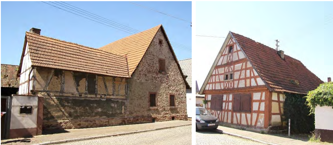
Abbildung 22: Gebäude mit erheblichen Baumängeln
