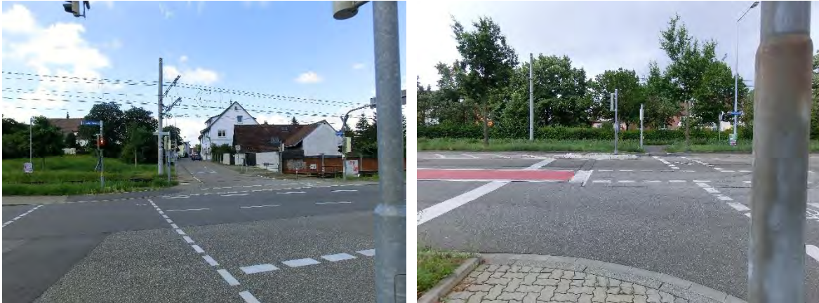
Abbildung 37: Problematische Querungstellen über die Rheinbrückenstraße
