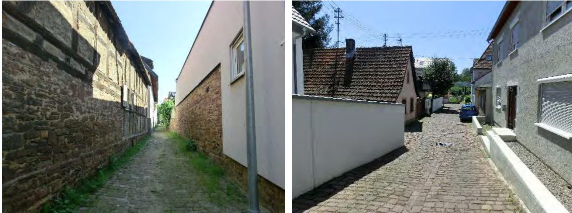
Abbildung 17: Historisches Pflaster in der Goldwäschergasse und Elsässer Straße
