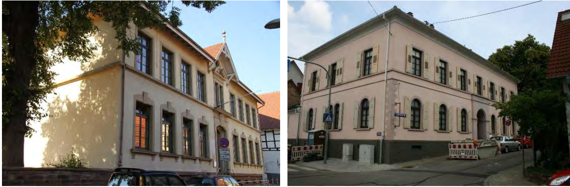
Abbildung 29: Grundschule Knielingen und daneben die Bürgerstätte des Bürgervereins (Eggensteiner Straße)
