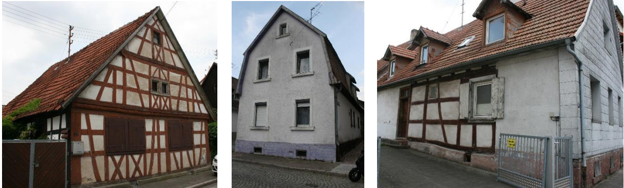
Abbildung 20: Unsanierte Gebäudesubstanz im ursprünglichen Erhaltungszustand (zum Teil unter Verkleidung)
