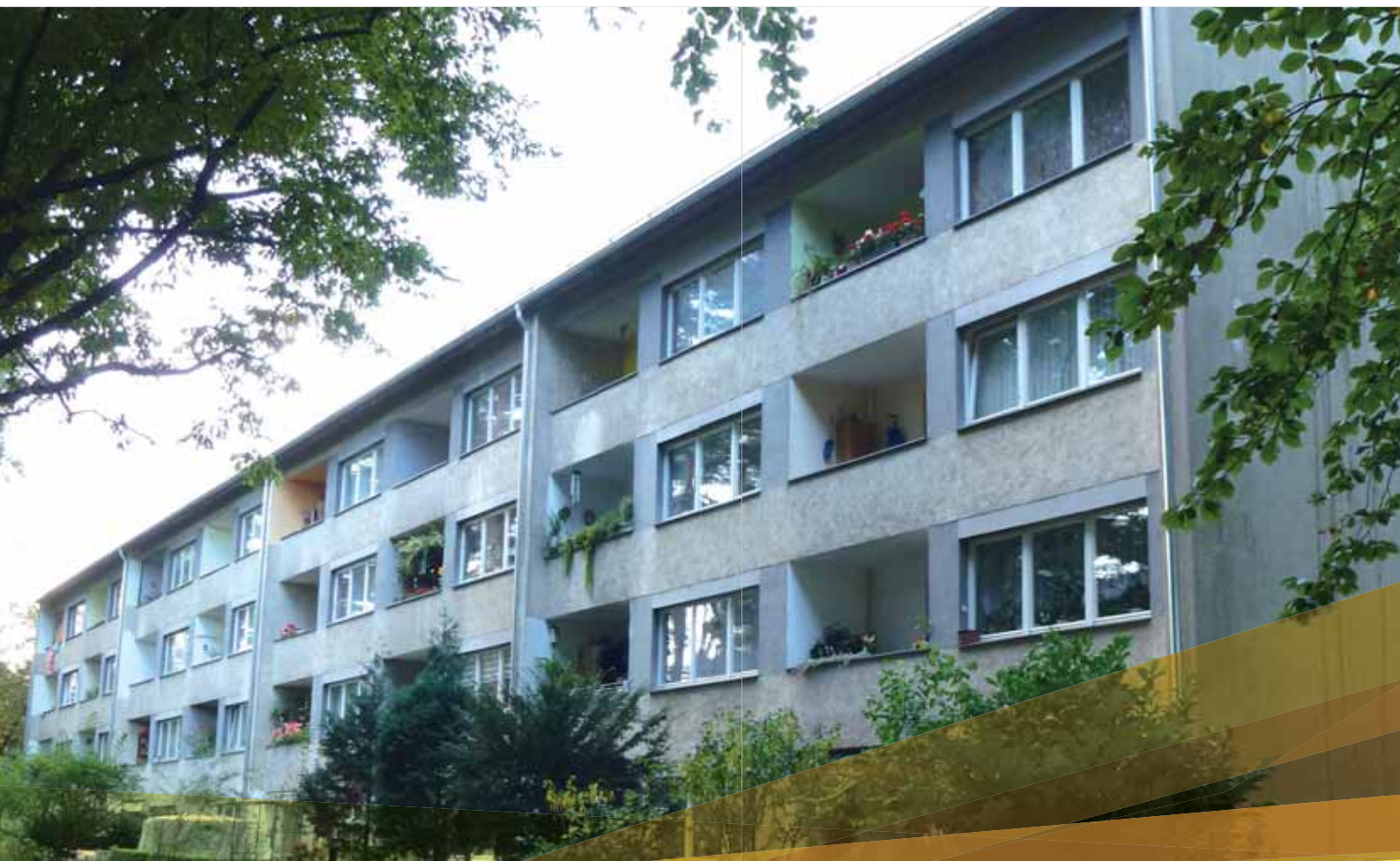
Foto 3: 60er-Jahre-Gebäude in der Waldstadt
