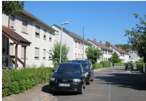
Charakteristisches Erscheinungsbild der Siedlungserweiterung um 1950. Zweigeschossige Zeilenbebauung in der Pfarrer-Blink-Straße.
