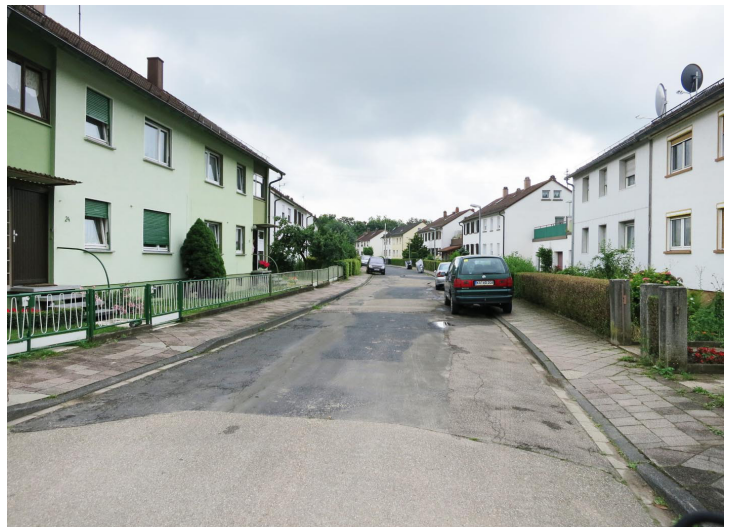
Funktionale und gestalterische Mängel in der Alten Karlsruher Straße (oben).
