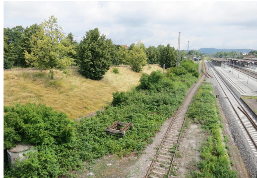
Räumliche und visuelle Barriere durch Gleiskörper und Lärmschutzwände
