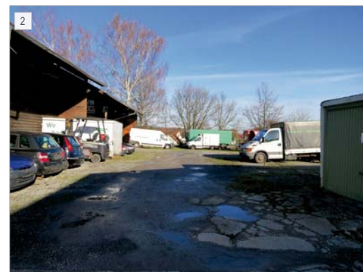
Die Gewerbeflächen des Becker-Areals sind nur zu einem Teil genutzt, der bauliche Zustand der Gewerbebauten ist nicht ausreichend.
