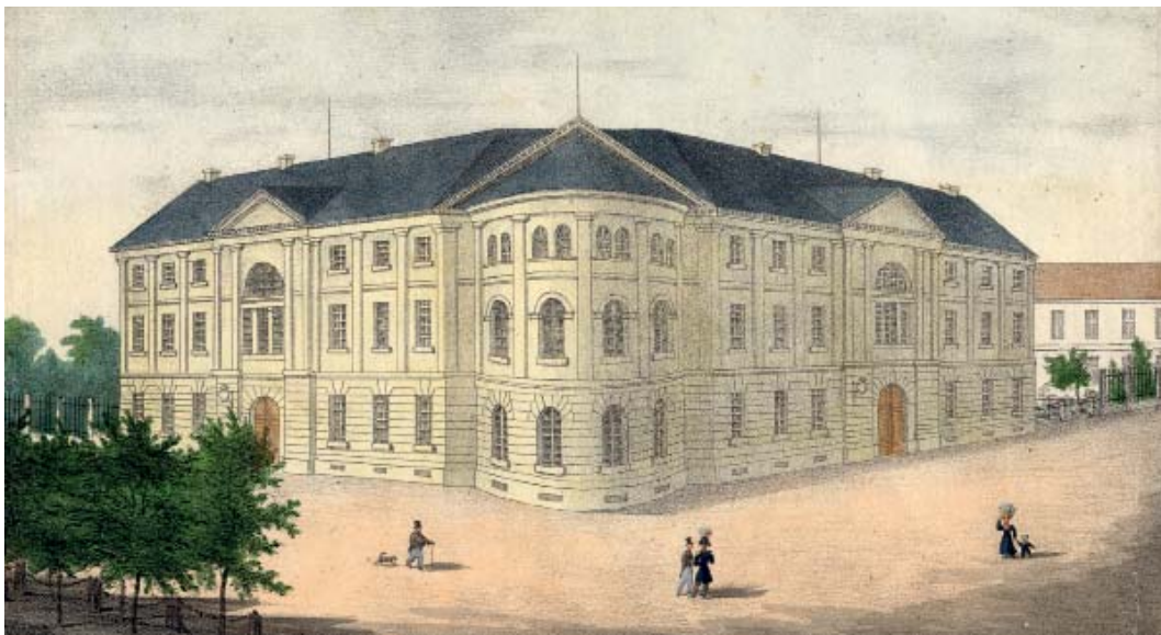
Das 1822 eingeweihte Ständehaus, das erste als Parlamentsgebäude errichtete Haus, Foto: Stadtarchiv
