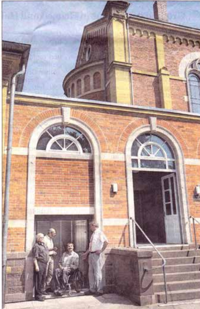
EIN AUFZUG ermöglicht jetzt Rollstuhlfahrern und Gehbehinderten den Zugang zur großen Kapelle im Hauptfriedhof. Foto: jodo
