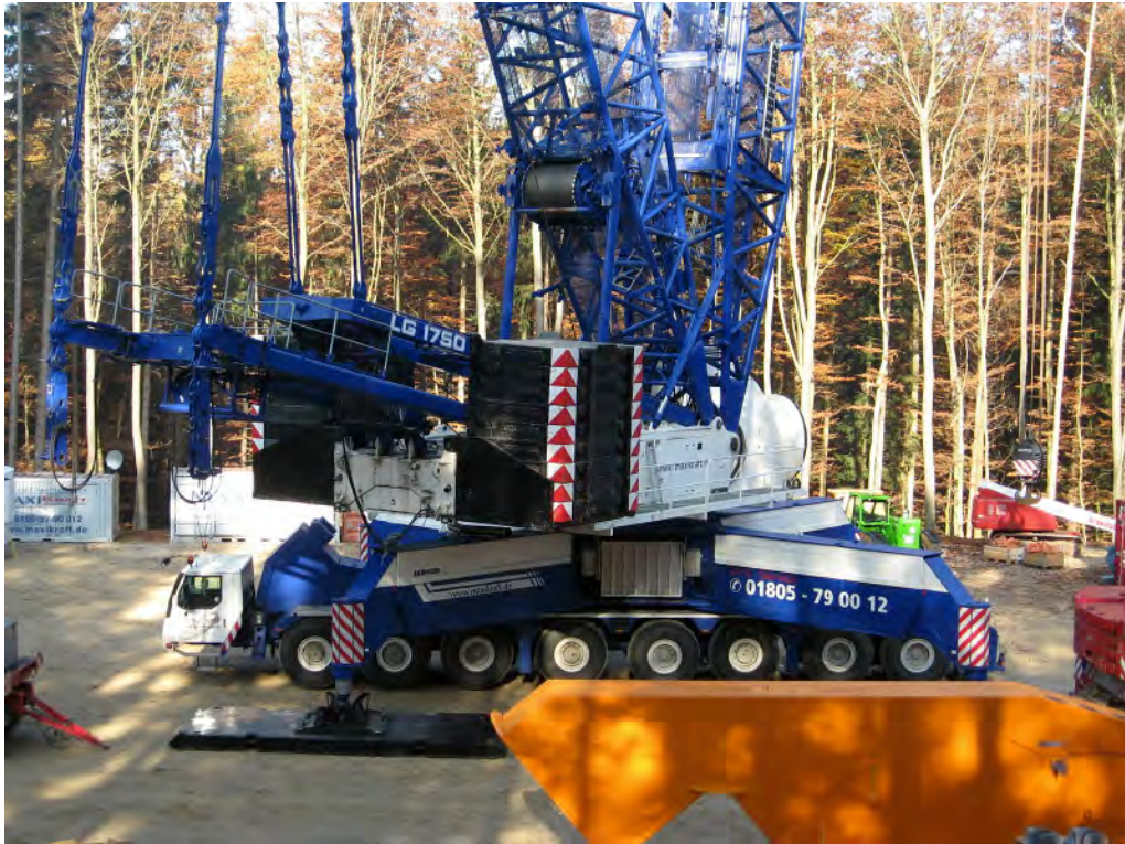
Abbildung 5: Kran zum Aufbau einer WEA im Wald
