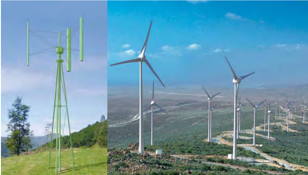
Abbildung 9: Beispiele für vertikale und horizontale Windenergieanlagen (hier: Notos H40 und E44)
