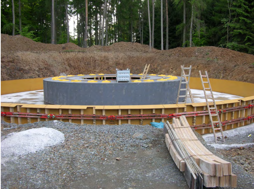
Abbildung 4: Fundament einer WEA
