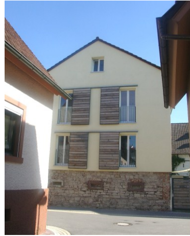
Beispiel Modernisierung von alter Bausubstanz
