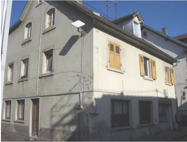
Wohngebäude im Gebiet (Ist-Situation)
