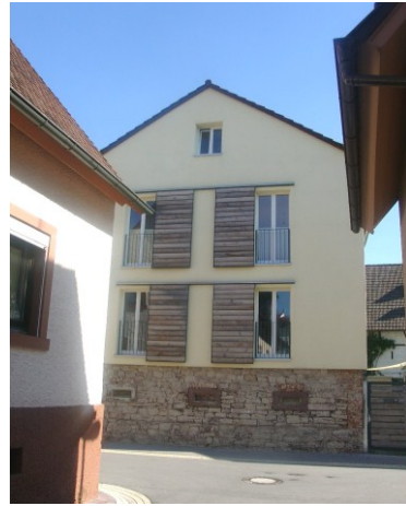
Beispiel Modernisierung von alter Bausubstanz
