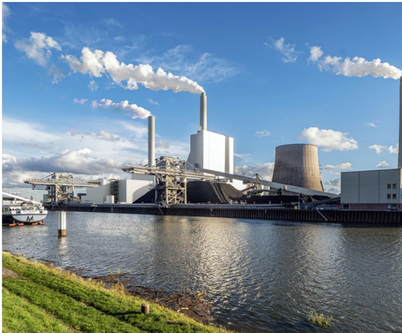
Abbildung 2: Ansicht des GuD-Kraftwerks (RDK 9) Blickrichtung aus Norden
