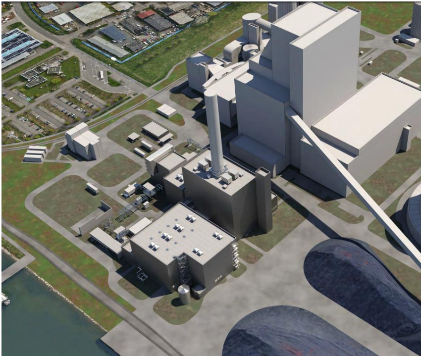
Abbildung 4: Fotomontage / Ansicht des geplanten GuD-Kraftwerks RDK 9
