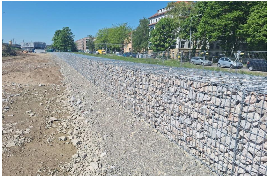
Abbildung 9: Im Bau befindliche Gabionen im BA 2, 29.04.2025 (Foto: Michael Bauer)
