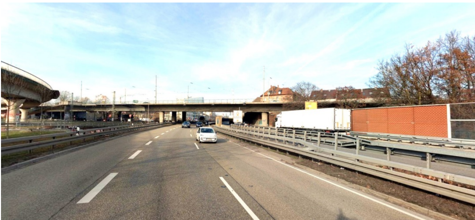
Bild 1 Vogesenbrücke von Osten
