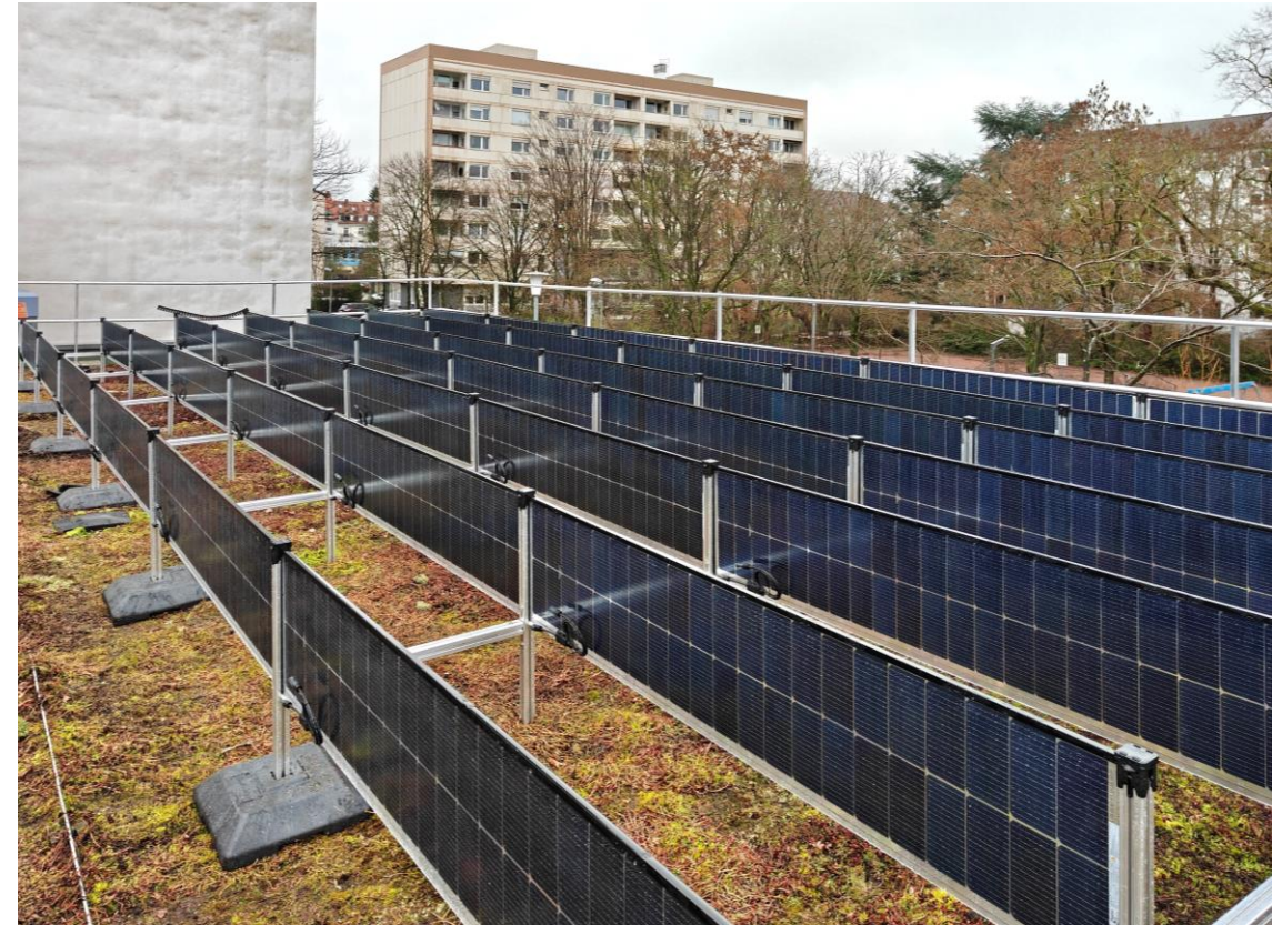
Vertikale PV-Anlage in Errichtung auf der Kita Welfenstraße
