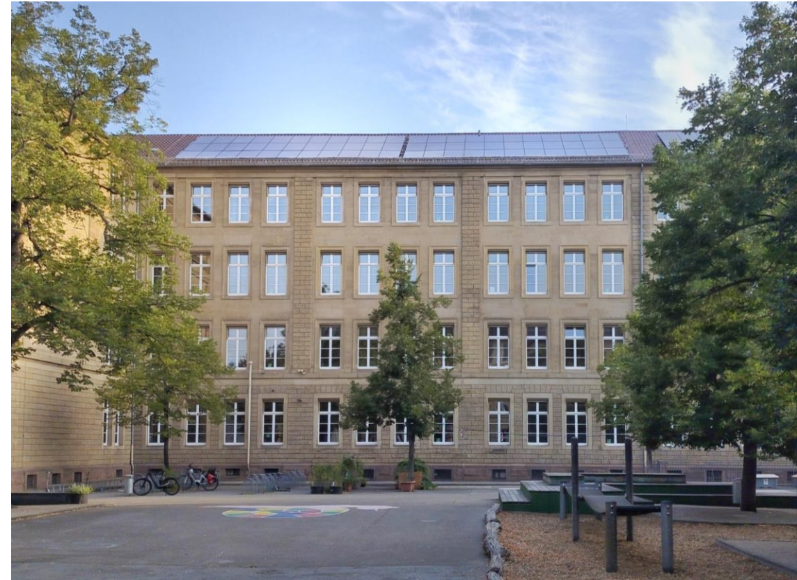
PV-Anlage auf der Südendschule
