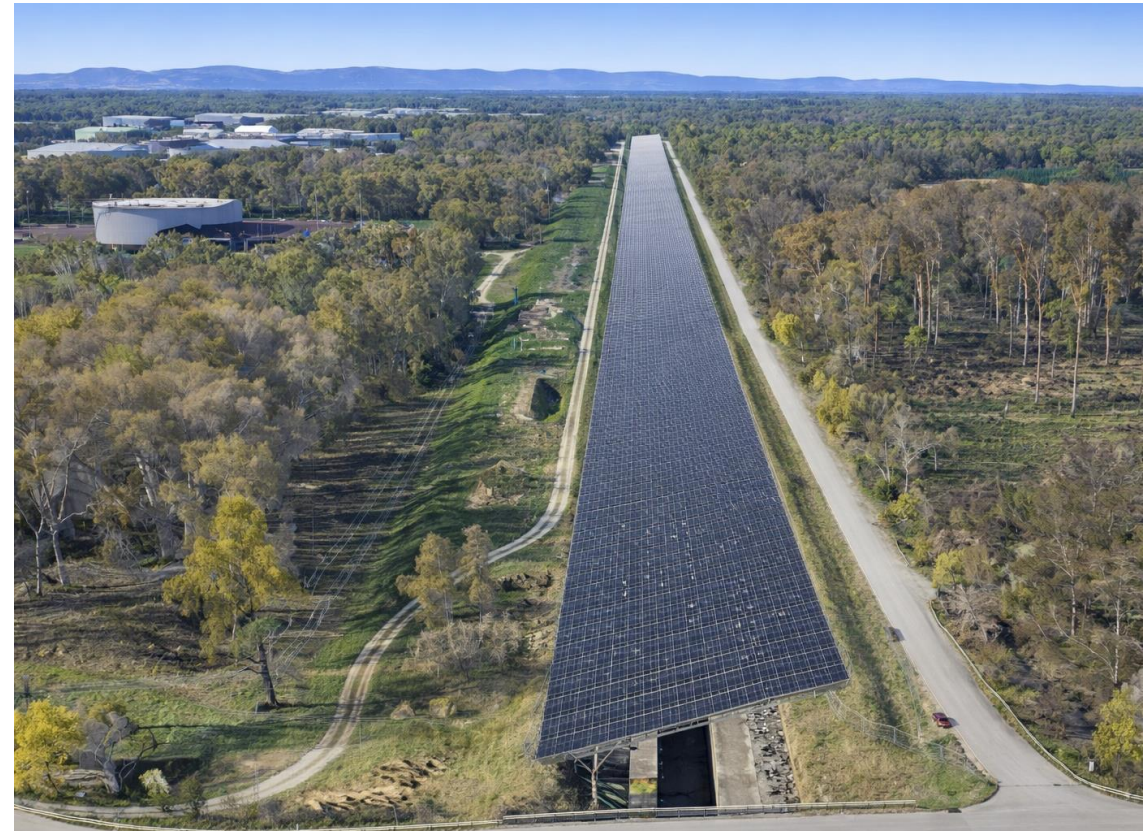
Visualisierung möglicher Gesamtausbau des Solarkanals am Klärwerk
