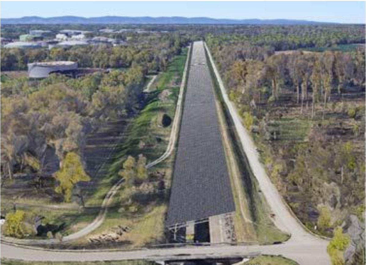
Abb.1 PV-Anlage über dem Ablaufkanal, Gesamtbauvorhaben
