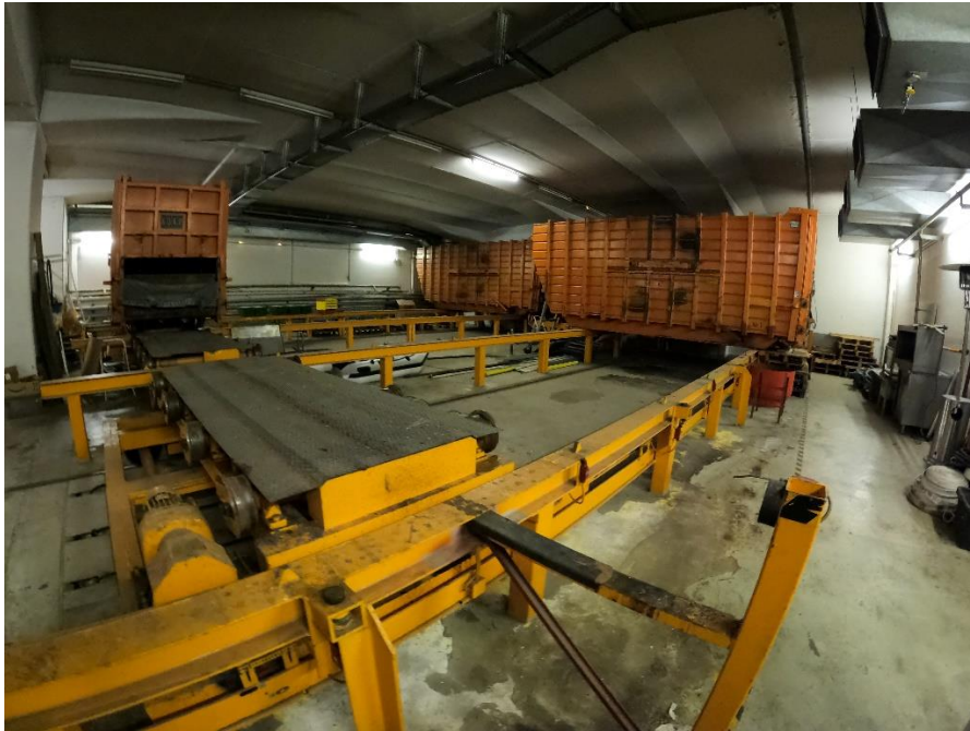
Abbildung 1: Pneumatische Müllentsorgungsanlage des Teams Sauberes Karlsruhe 1
