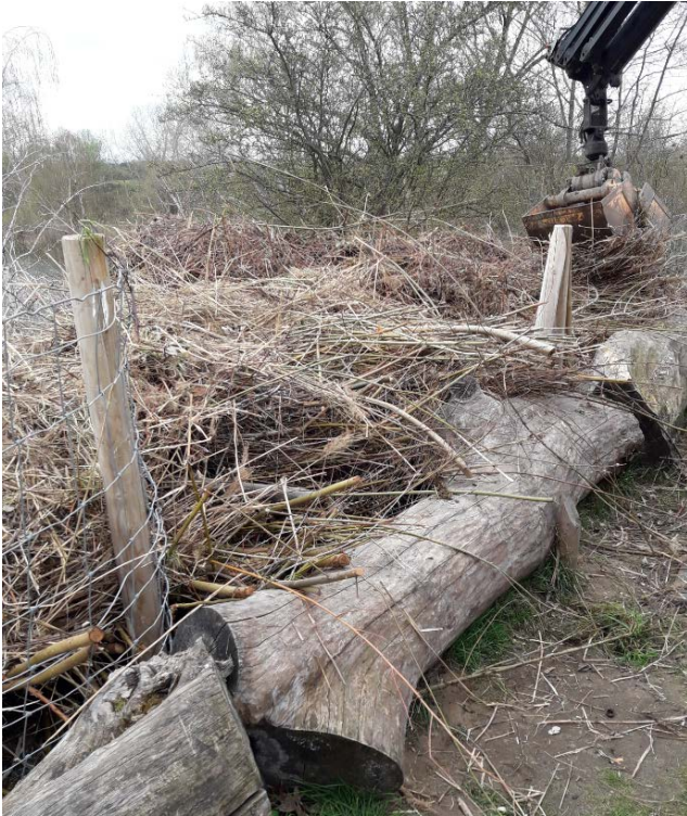
2022 - direkt nach Auftrag
