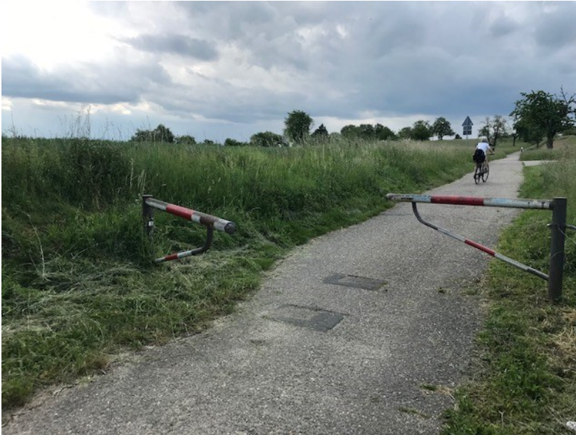
Schranke – wenn der Arretierungsspielraum voll ausgenutzt wird (die Durchfahrt ist möglich – ohne anzuhalten)
