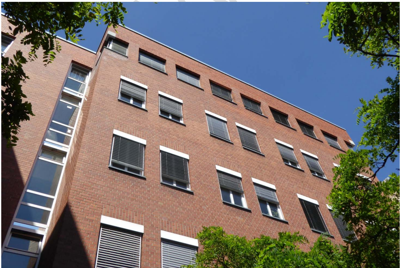
Abbildung 52: Vor allem im Gebäudebestand können Wärmeverluste im Winter und geringer Wärmeschutz im Sommer ein Thema sein. Foto: Stadt Karlsruhe, Umwelt- und Arbeitsschutz.
