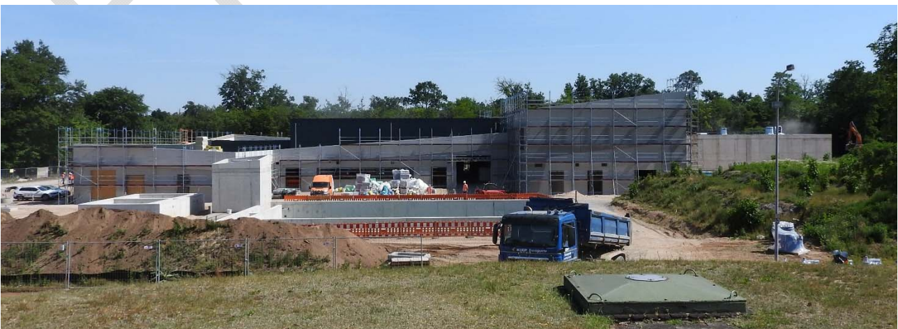
Abbildung 83: Baustelle des Wasserwerks Mörscher Wald. Foto: Stadtwerke Karlsruhe.
