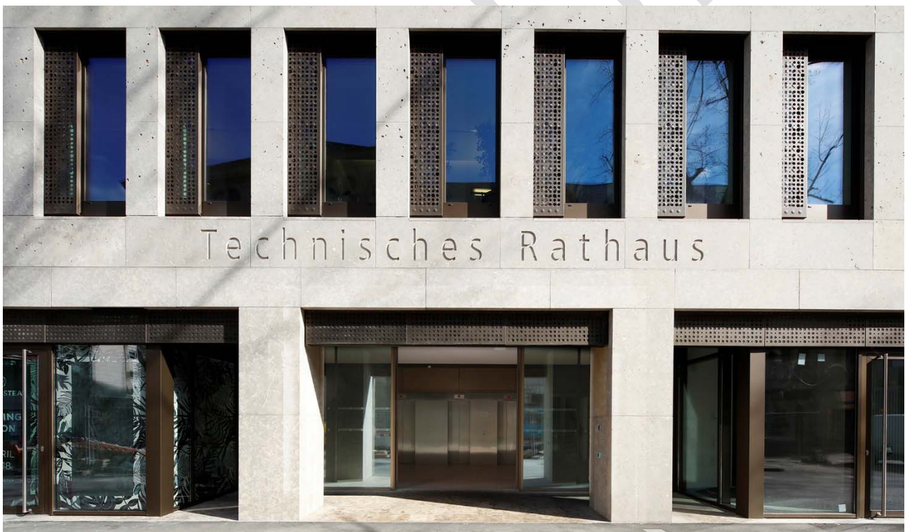
Abbildung 54: Lüftungsklappen am Technischen Rathaus Karlsruhe. Foto: Atelier Dirk Altenkirch.
