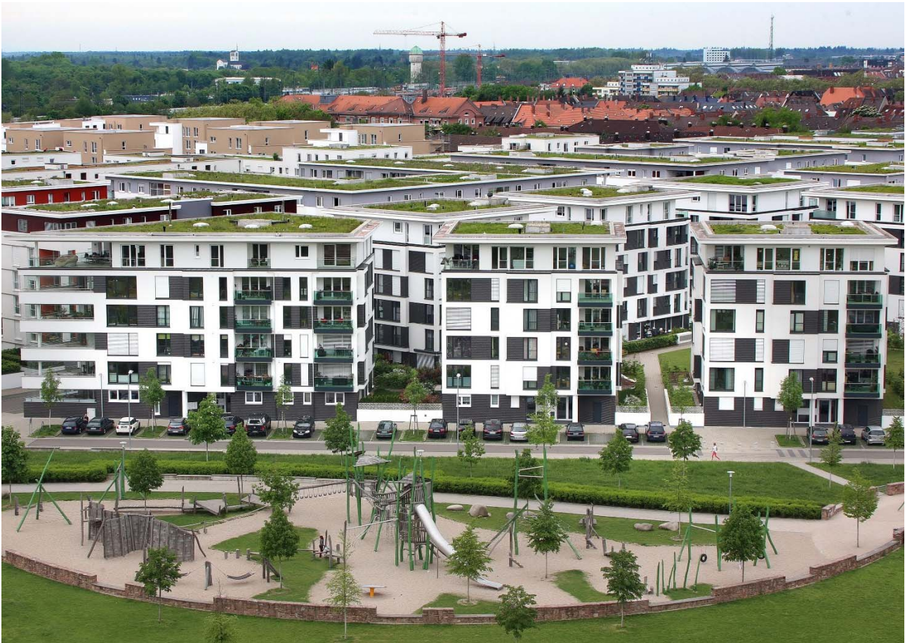
Abbildung 42: Extensive Dachbegrünung, eine Gebäudestellung, die die Durchlüftung erlaubt, begrünte Hinterhöfe und im Vordergrund die Parkfläche des Cityparks in Karlsruhe-Südost. Foto: Stadt Karlsruhe, Presse- und Informationsamt (Fränkle).
