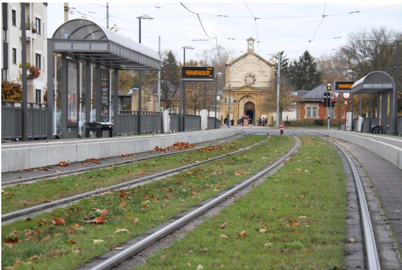
Abbildung 100: Im Jahr 2017 gebautes Rasengleis an der Haltestelle Hauptfriedhof. Foto: Verkehrsbetriebe Karlsruhe (Krauth).
