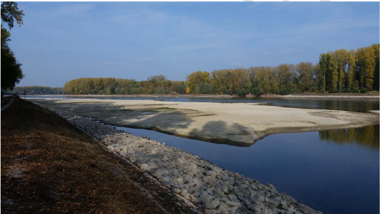
Abbildung 78: Niedrigwasser am Apothekergrund (Rhein-km 378) im Jahr 2018. Foto: Wasserstraßen- und Schifffahrtsamt Oberrhein.
