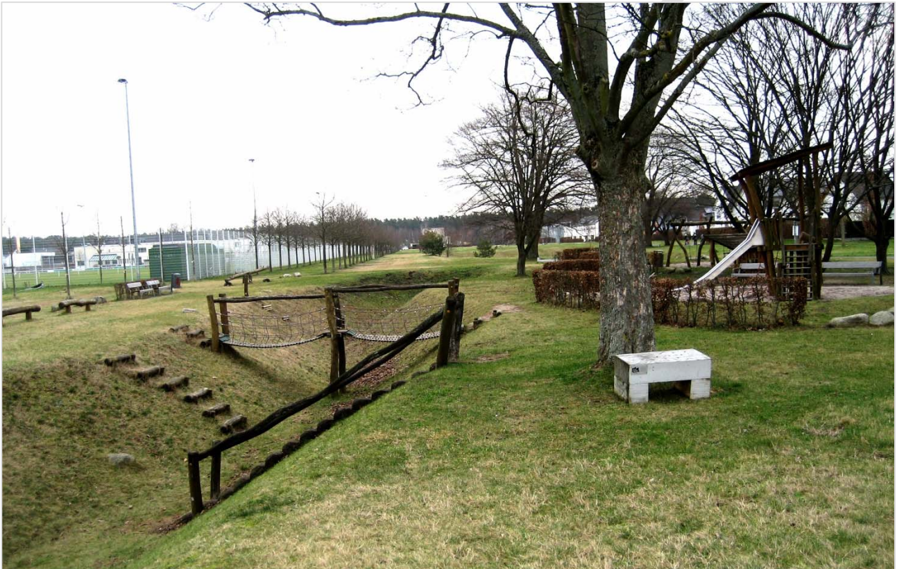
Abbildung 88: Versickerungsmulde in Neureut mit Spielplatz. Foto: Stadt Karlsruhe, Tiefbauamt.
