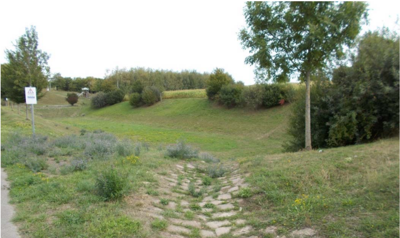
Abbildung 86: Regenrückhaltebecken Ob den Gärten; Foto: Stadt Karlsruhe Umwelt- und Arbeitsschutz (Huhn).
