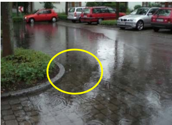
Abbildung 89: Rückhaltevolumen in der Straße durch Einborden. Fotos: Stadt Karlsruhe, Tiefbauamt.
