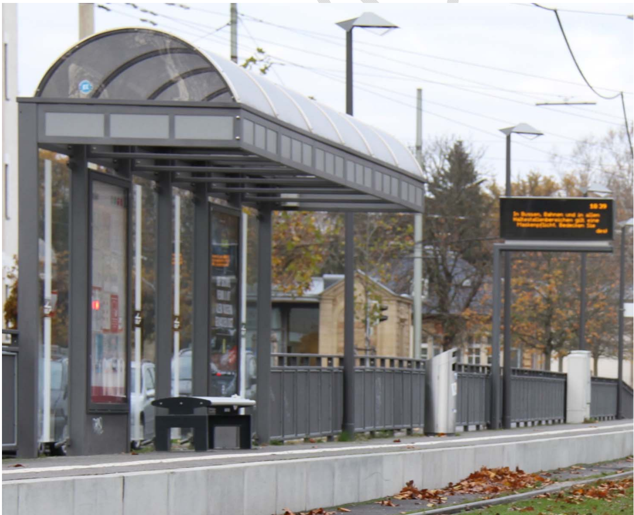
Abbildung 105: Ein Karlsruher Haltestellenwartehäuschen. Foto: Verkehrsbetriebe Karlsruhe (Krauth).
