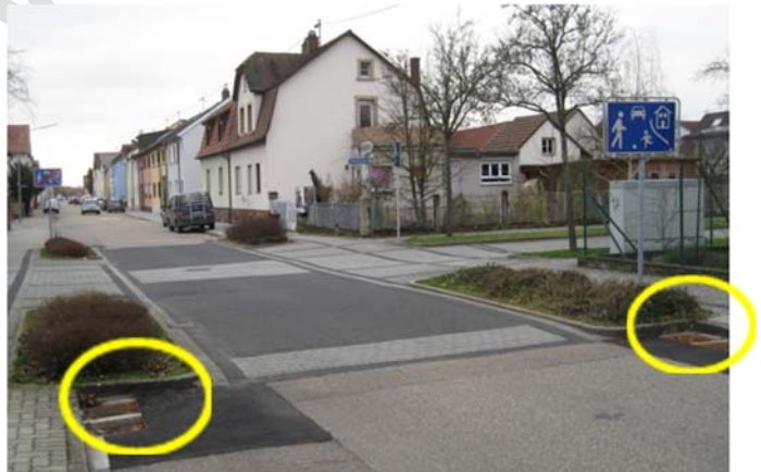
Abbildung 90: Straße mit doppelten Straßeneinläufen. Fotos: Stadt Karlsruhe, Tiefbauamt
