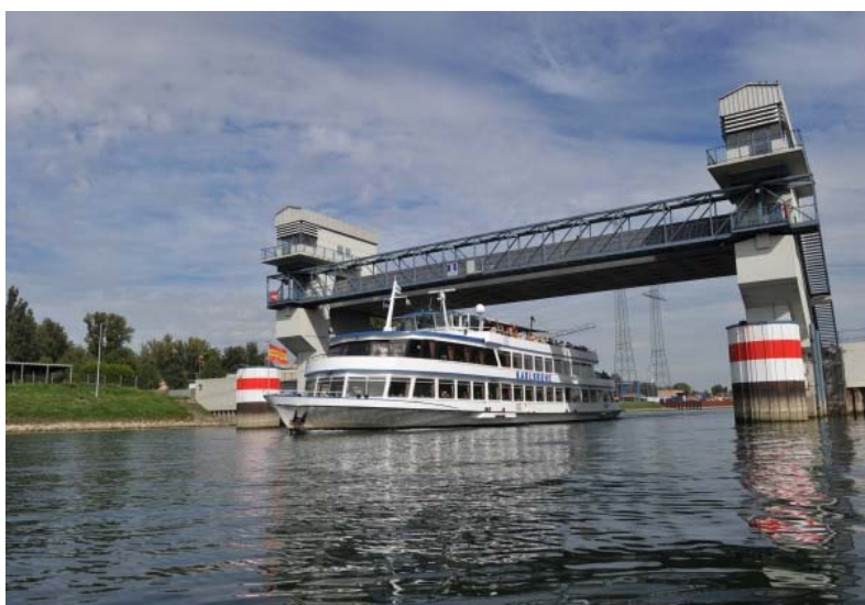
Abbildung 97: Hochwassersperrtor im Karlsruher Rheinhafen. Foto: KVVH GmbH – Geschäftsbereich Rheinhäfen.
