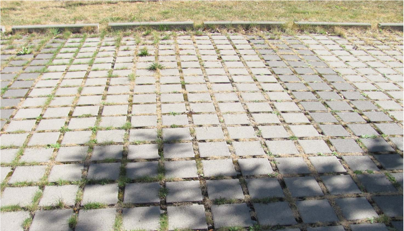
Abbildung 93: Wasserdurchlässige Materialien erlauben die Versickerung und reduzieren den Grad der Versiegelung. Foto: Stadt Karlsruhe, Umwelt- und Arbeitsschutz.
