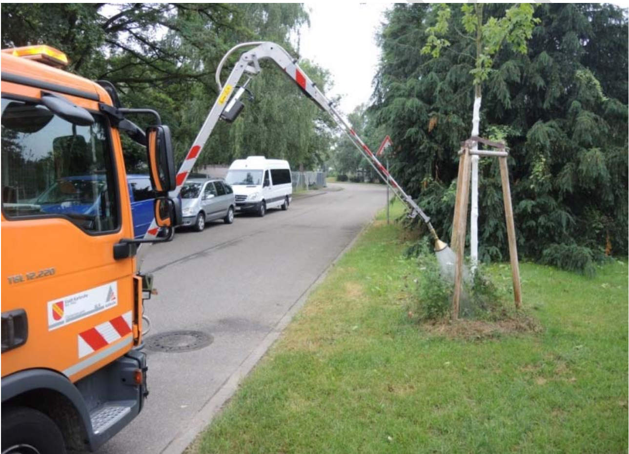
Abbildung 62: Mit der Teleskop-Lanze effizient wässern. Foto: Stadt Karlsruhe, Gartenbauamt.
