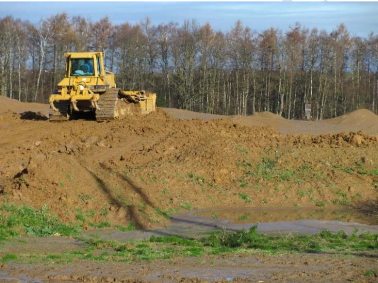
Abbildung 33: Bauarbeiten auf nassem Boden. Foto: Stadt Karlsruhe, Umwelt- und Arbeitsschutz (Bellm).
