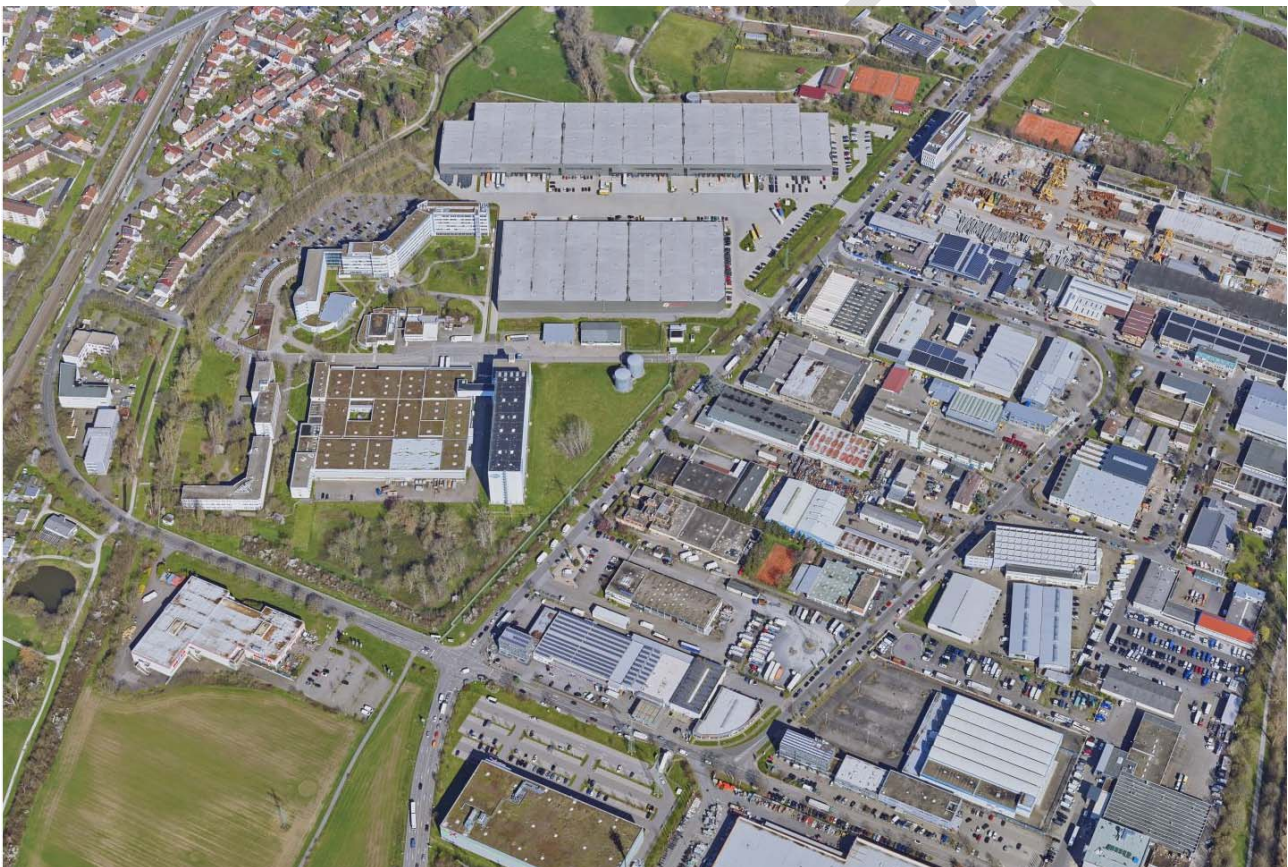
Die Gewerbegebiete Am Storrenacker und An der Tagweide. Luftbild: Stadt Karlsruhe, Liegenschaftsamt.
