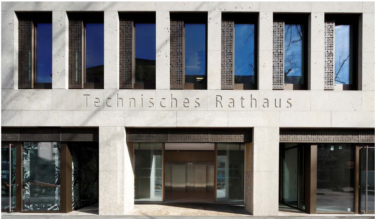
Abbildung 28: Nachtlüftungskappen an den Fenstern des technischen Rathauses erlauben, nachts kühlere Luft ins Gebäude zu leiten, ohne dass Fenster ungesichert offenstehen. Foto: Atelier Dirk Altenkirch.
