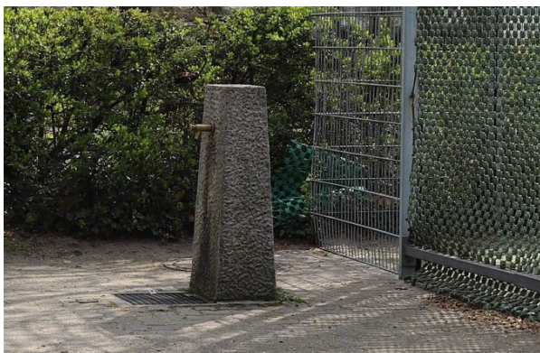
Abbildung 32: Trinkbrunnenmodell aus Granit mit Hahn und Drückergarnitur für den kontinuierlichen Betrieb, Foto: Katrin Korth
