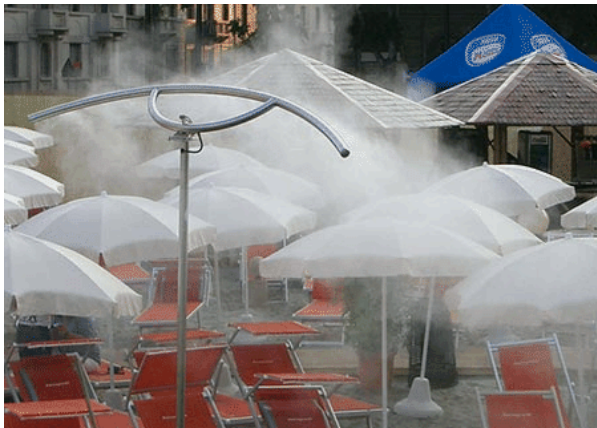
Abbildung 10: Nebelduschen bei Freiluft-Veranstaltungen in Wien, Foto: Rauch Luftbefeuchtung Österreich
