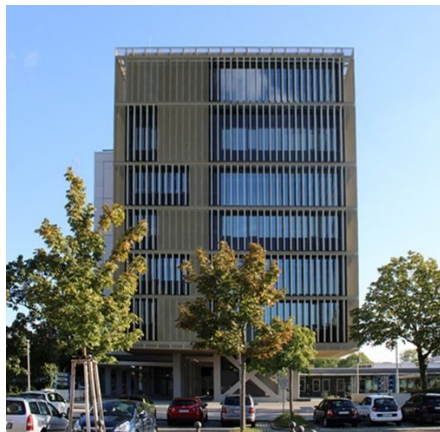
Nordfassade Erweiterung mit Bestand (Foto Architekturbüro Heid)
