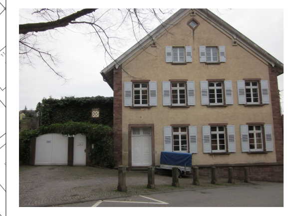
Am Steinhäule 8 (Flst.Nr. 0-70158), §2 Altes Schulhaus, 1846, 1983 zur Altbauwohnung mit großen Fenstern umgebaut, nord-, Scheune abgetrochen, deren Nord- und Ostwand dabei in einen Garagenbau integriert
