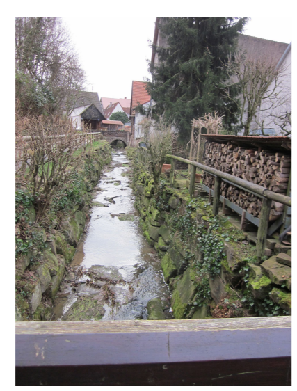
Bachgasse (Flst.Nr. 0-70082), §2 Gewölbebrücke aus rotem Sandstein mit niedriger Brüstungsmauer, Ende 19. Jahrhundert
