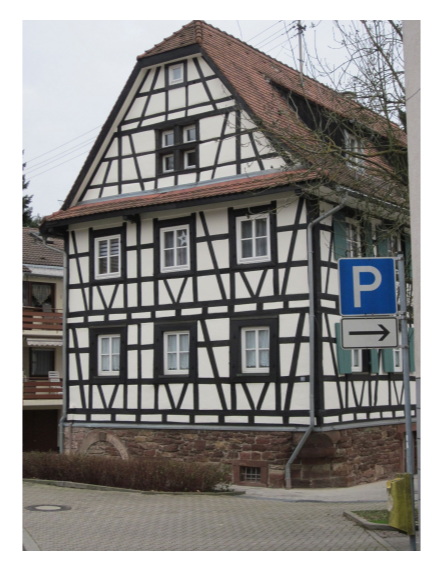
Wetterbach 31 (Flst.Nr. 0-70043), §28 Fachwerkhaus, zweigeschossig über hohem massivem Keller, geschosst mit Rundbogeneingang und Eckkornle, bez. GB 1799
