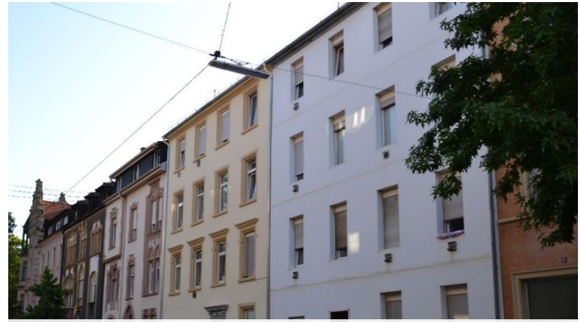
Aufeinandertreffen unterschiedlicher Fassadengestaltungen
