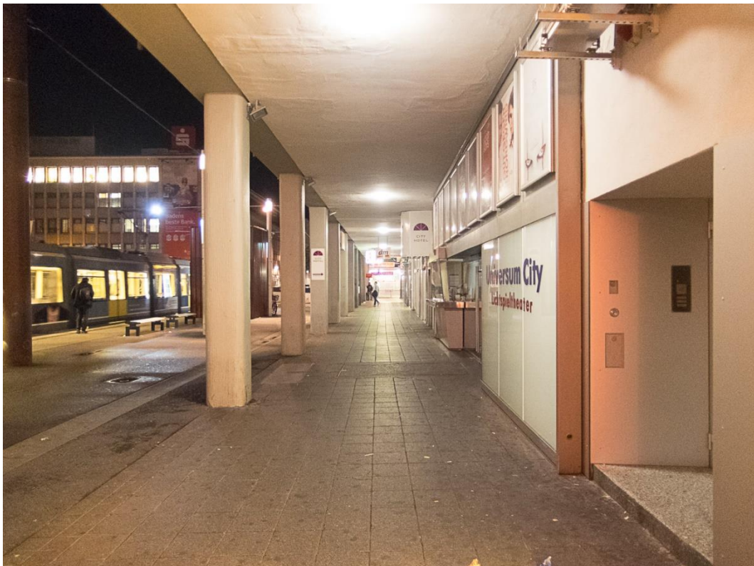
Öffentliche Beleuchtung der Arkaden am Europaplatz nach Umrüstung auf LED-Leuchtmittel und Aufwertung auf ca. 15 lux im Mittel, 26.09.19
