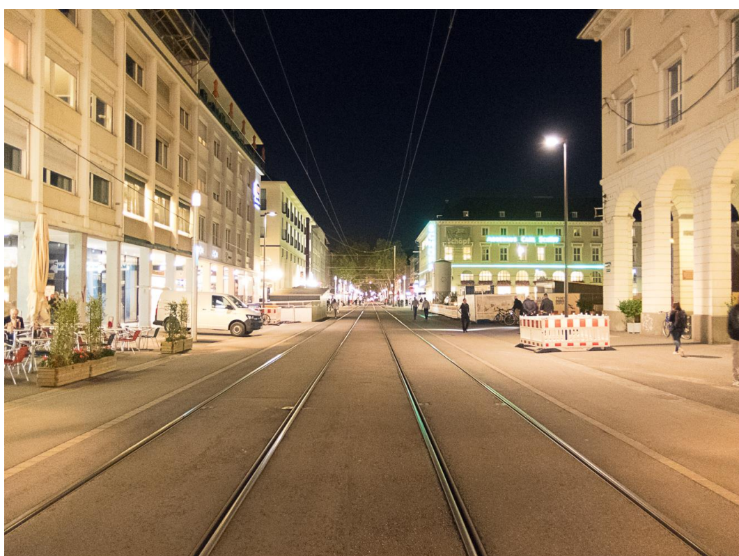
Musterbeleuchtung Kaiserstraße (zwei Masten mit Einzelkopfleuchte) am 14.10.19
