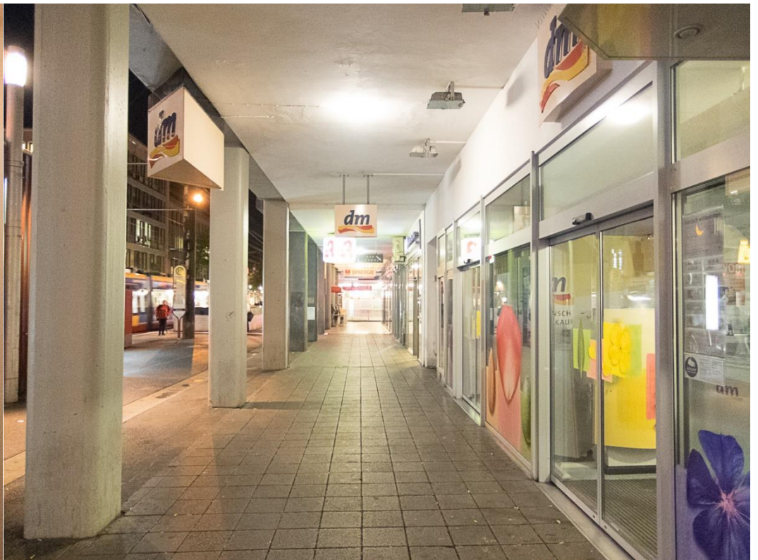
Öffentliche Beleuchtung der Arkaden am Europaplatz nach Umrüstung auf LED-Leuchtmittel und Aufwertung auf ca. 15 lux im Mittel, 26.09.19
