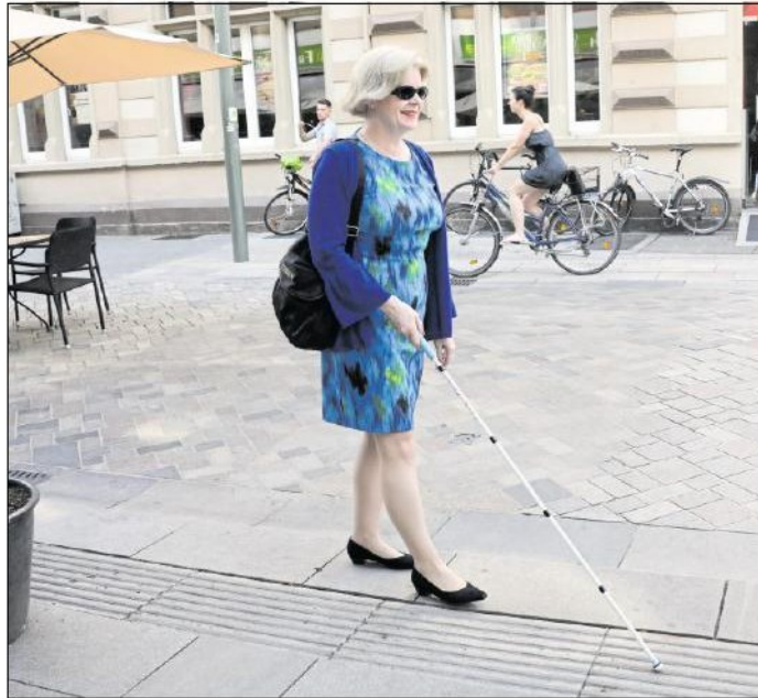
DIE RILLEN des Betonprofils geben Elke Wagner Orientierung in der Kreuzstraße am Rand der Fläche, auf der die Stadt einen Bodenbelag für die Kaiserstraße der Zukunft testet. Fotos: jodo
