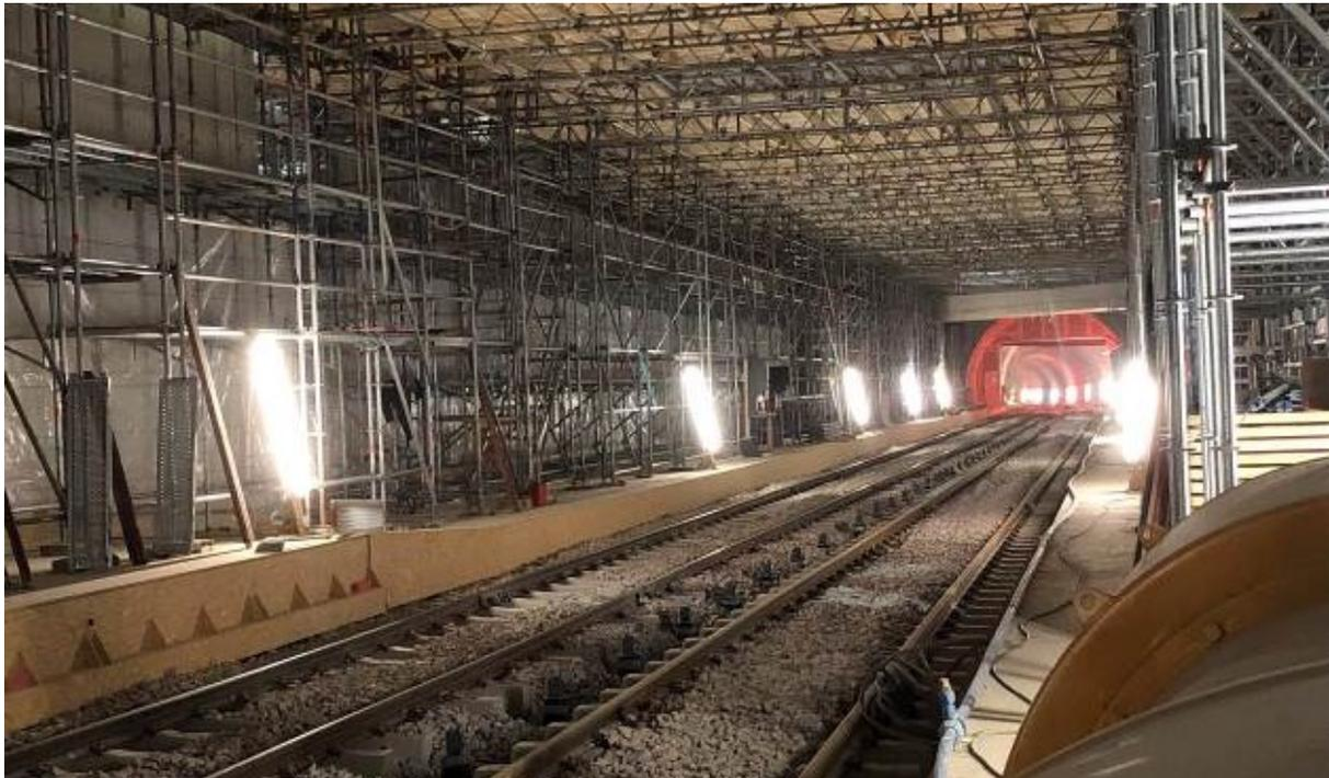
Die Gleise auf dem Ost-Ast sind verlegt und ziehen sich vom Gleisdreieck Marktplatz bis zum oberen Ende der Rampe in der Durlacher Allee.
